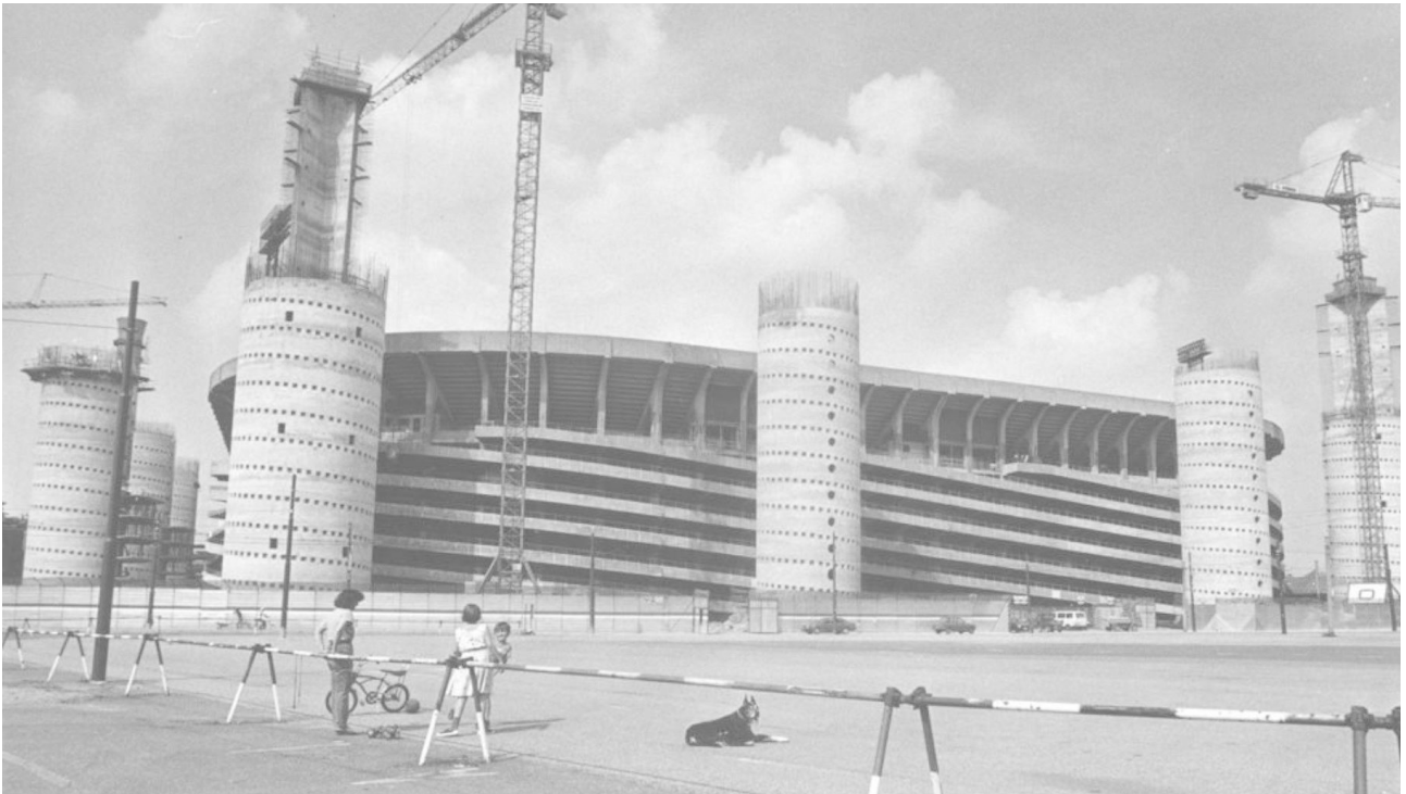
FIG. 10 - Costruzione delle torri e degli impianti di risalita per l'accesso dall'esterno. FONTE: https://buildingcue.it/san-siro-storia-architettonica-dello-stadio-piu-importante-ditalia/11885/ (© PassioneStadi)
