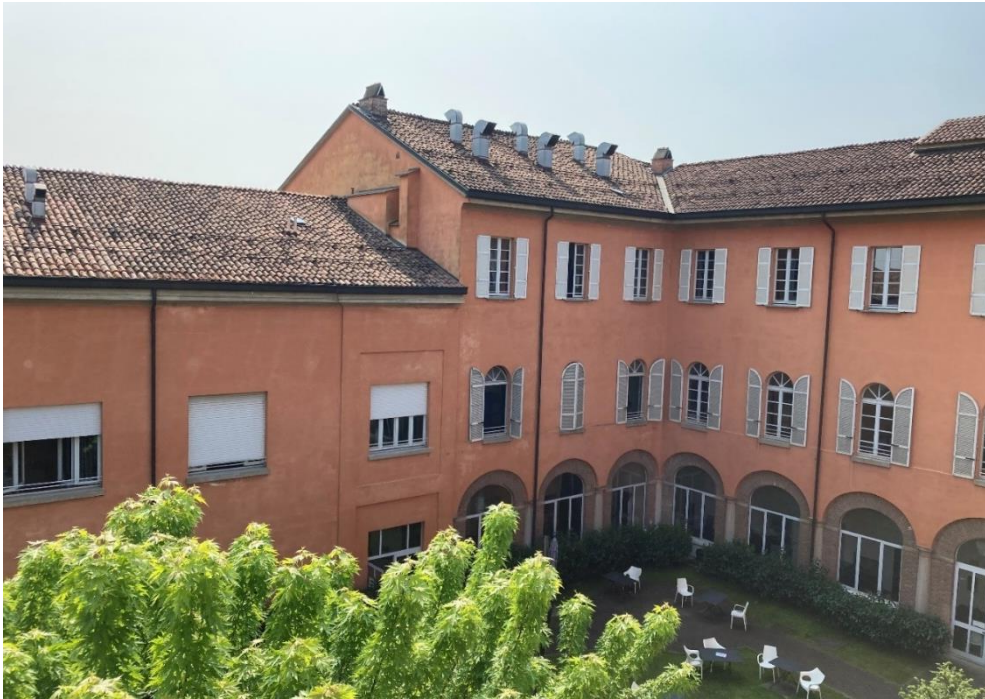
Figura 2.28: Facciata della prima corte interna
