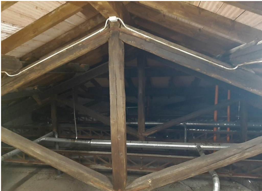
Figura 2.45: Copertura a capriate lignee
