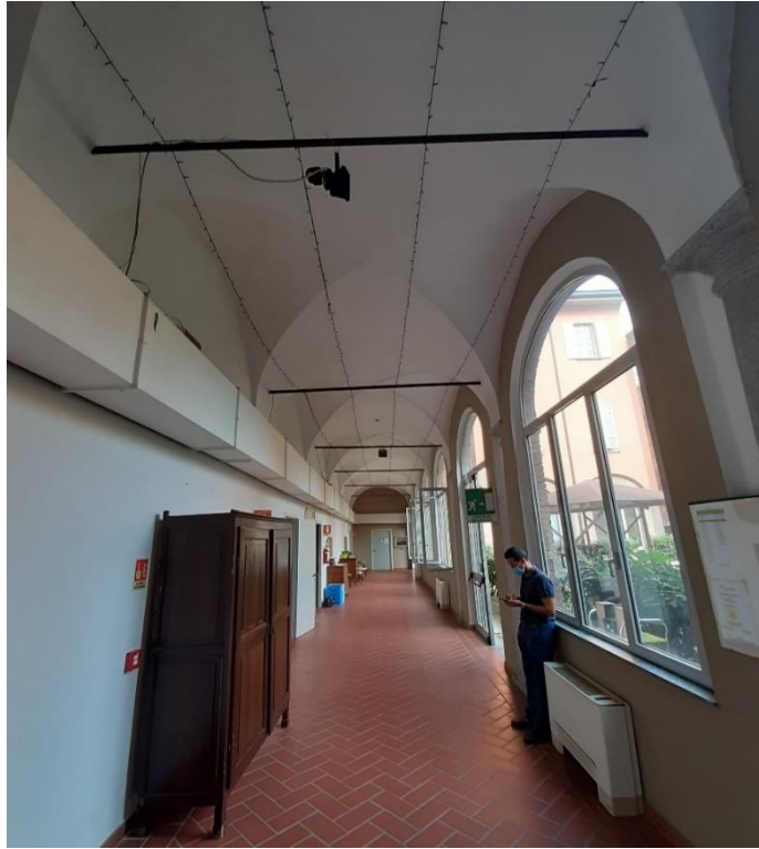
Figura 2.34: Corridoio voltato della prima corte
