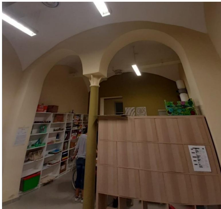
Figura 2.41: Volte a vela sorrette da una Colonna in ghisa
