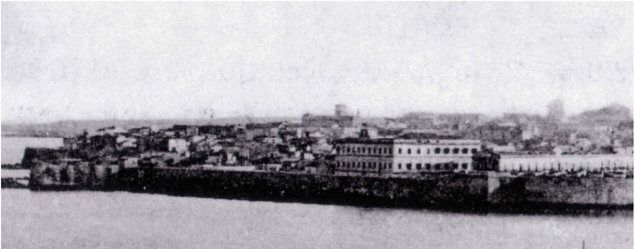
3.5. Fotografia del 1875 di G.Sommer che ritrae l'area del parcheggio Talete appena prima della demolizione delle mura spagnole
