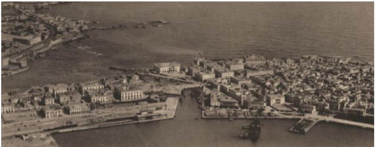
2.17. Foto d'epoca della Darsena e del nuovo quartiere Umbertino del 1920
