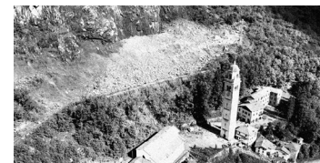
Frana lungo la strada per Madesimo.
