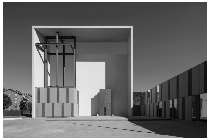
Vista ingresso, fronte Ovest
