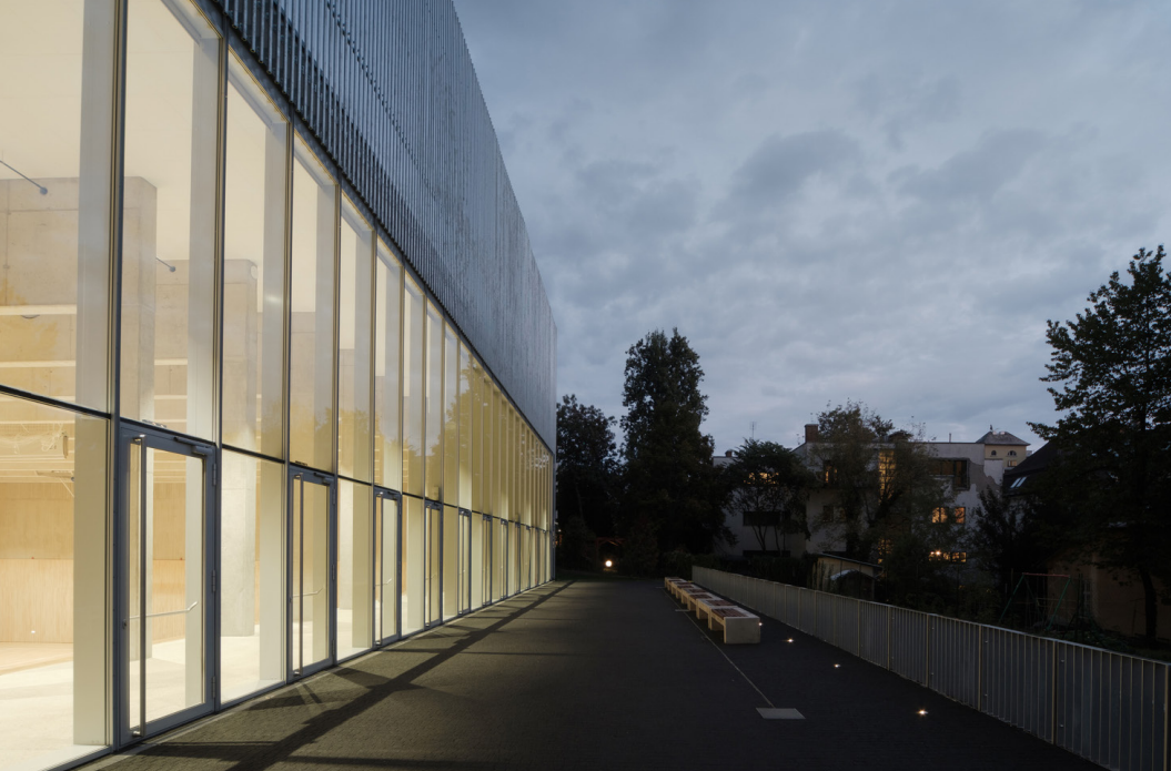
Vista esterna, ritmica della facciata principale d'accesso per il pubblico
