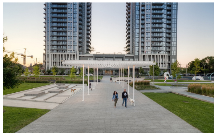
Vista di dettaglio, installazione reversibile coperta
