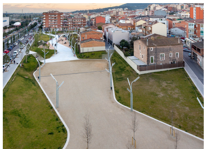
Vista sulle due differenti tipologie di pavimentazioni presenti.
