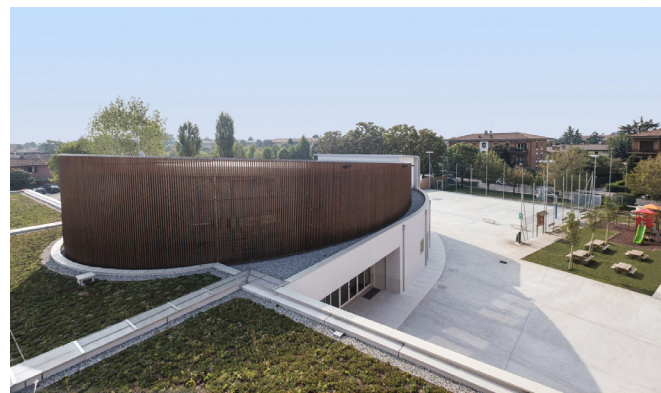
Vista di dettaglio, scorcio su coperura con sistema giardino pensile
