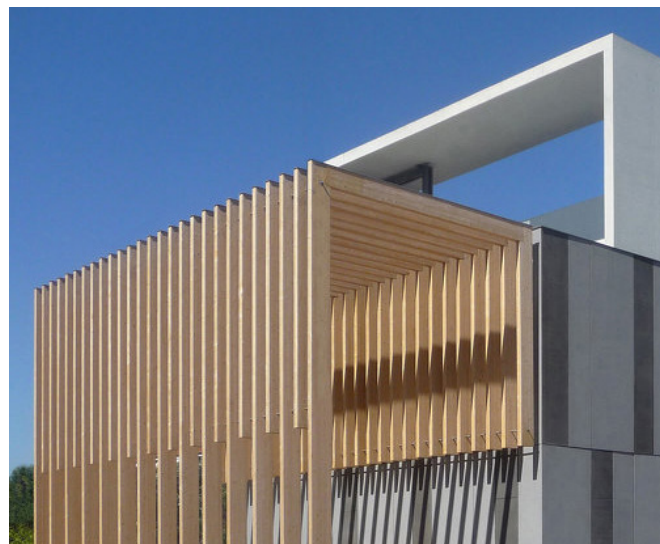
Vista di dettaglio su aspetti compositivi e qualità componente materica, facciata Sud-Ovest
