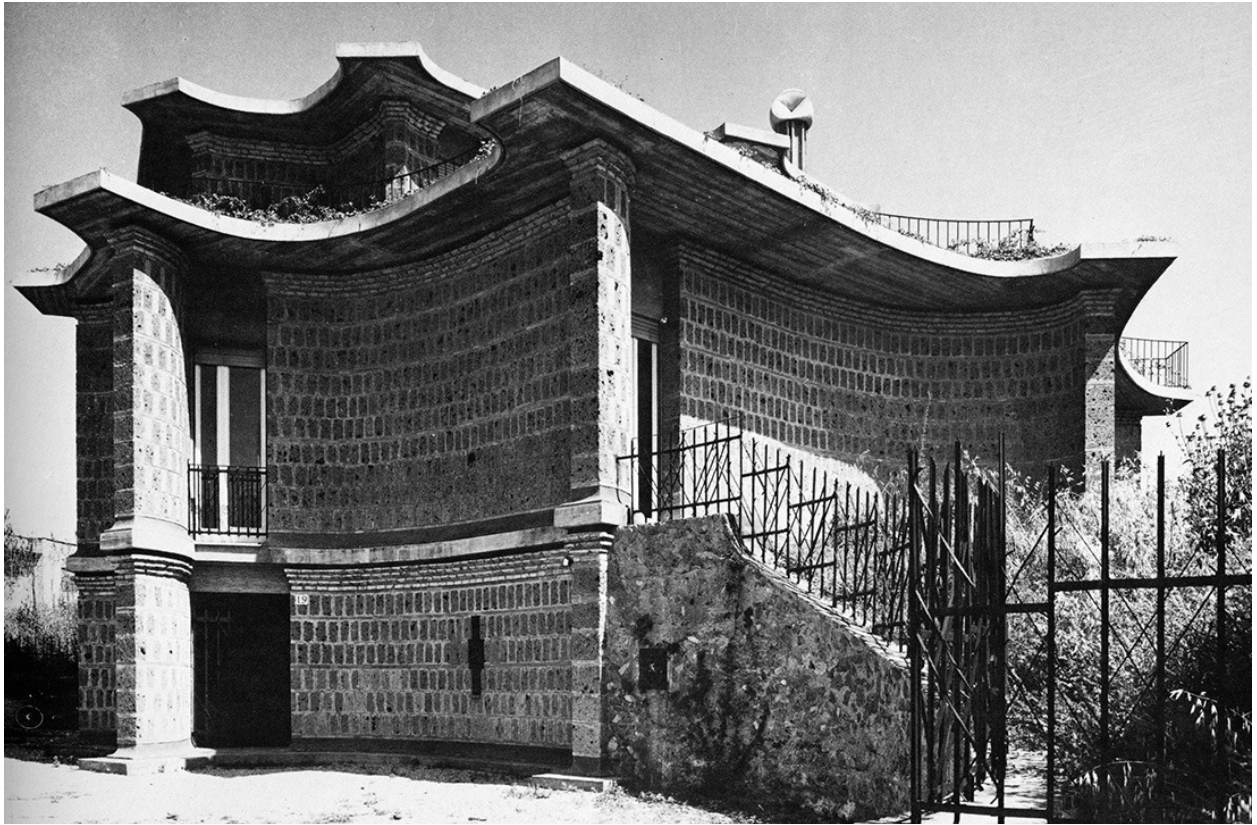
Figure 3.18: A photo of Casa Baldi, Paolo Portoghesi.
