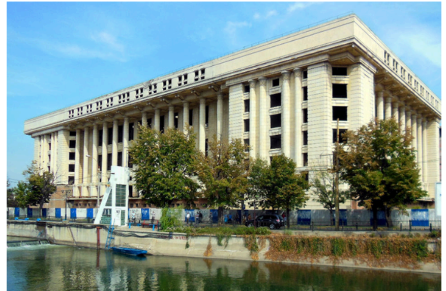
Casa Radio(The Dâmbovița Center)
