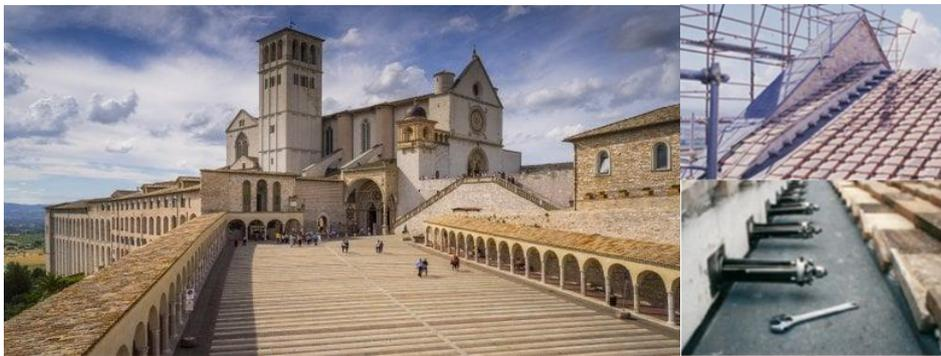
Figure 2-17: Retrofit of Basilica di San Francesco di Assisi with SMA devices
