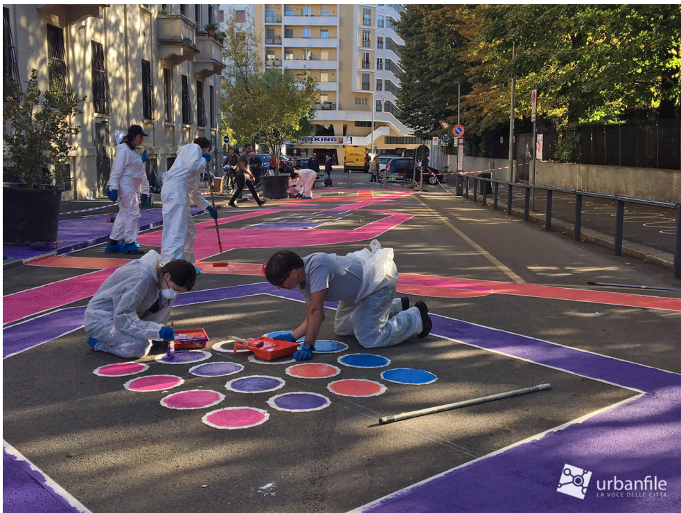
83. Intervento di pedonalizzazione in via Reni
