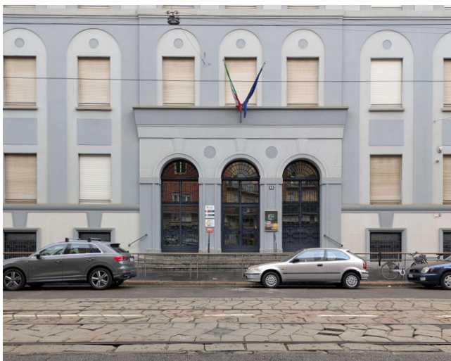
55. Ingresso della scuola secondaria di primo grado Faes
