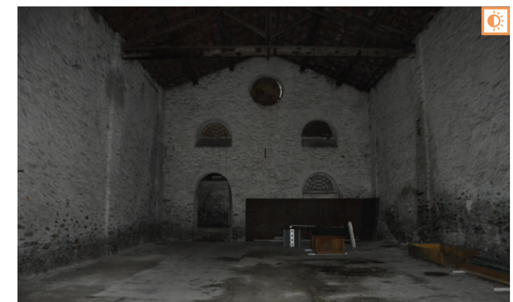
Interno del capannone C
