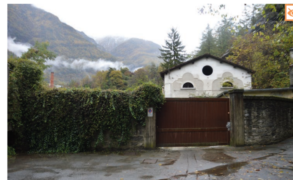
Cinta muraria di confinamento dell'intero lotto
