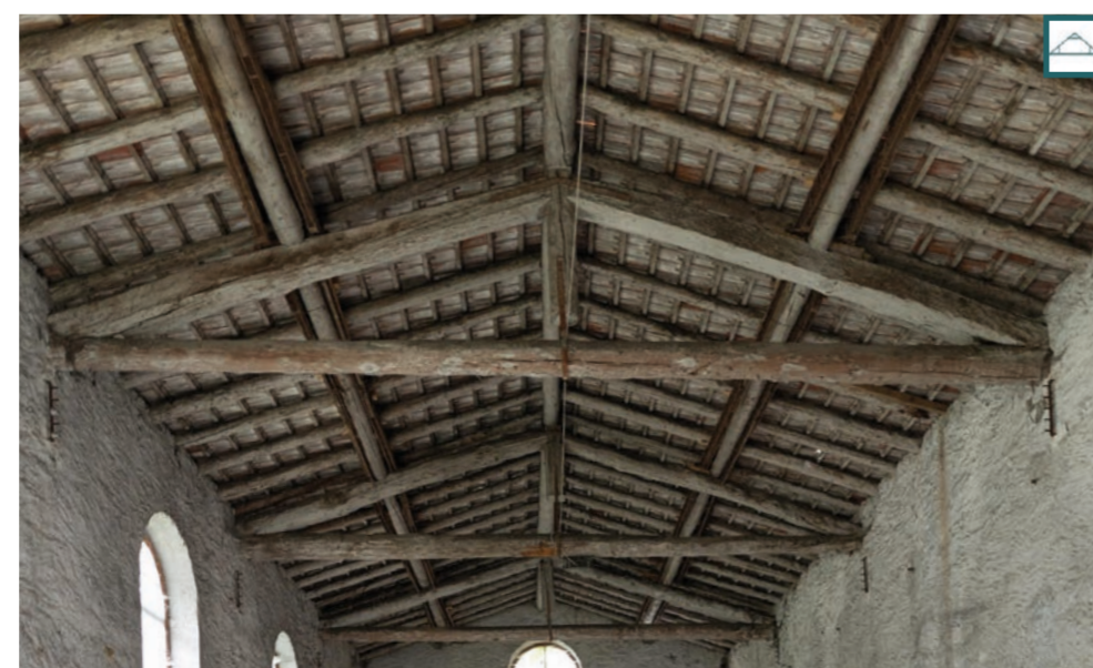
Copertura originale del capannone B con struttura a capriate lignee
