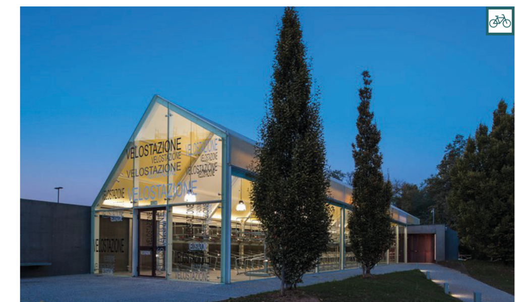
LFL Architetti, Velostazione di Cesano Maderno (tratto da: https://www.archiportale.com )
