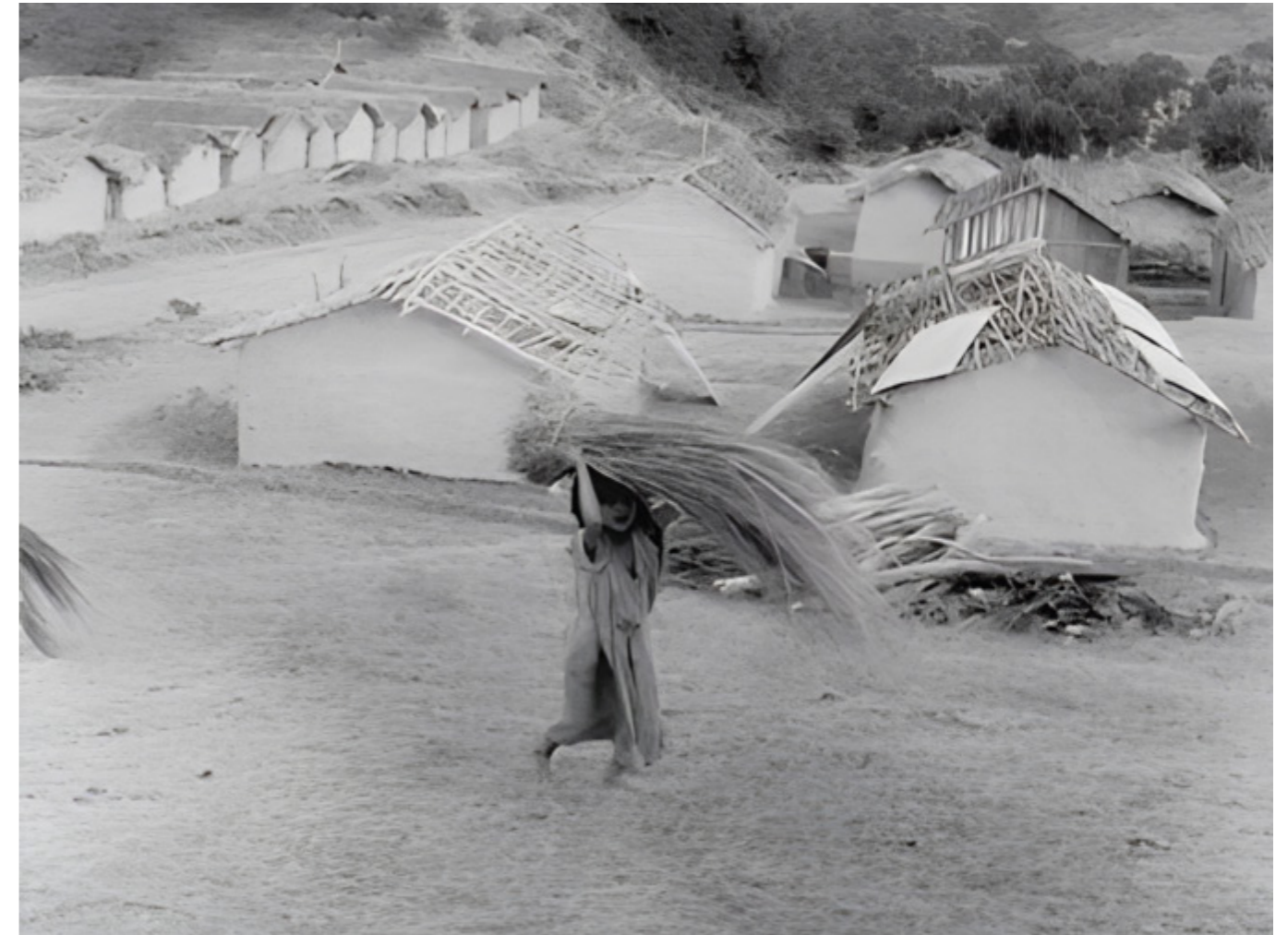
Fig. 11 Cheraïa Regrouping Center under construction
