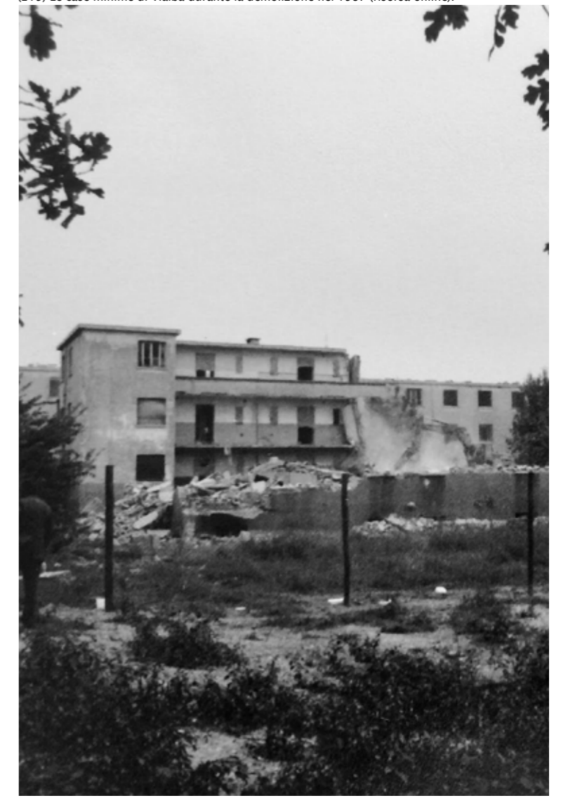
(215) Le case minime di Vialba durante la demolizione nel 1987 (risorsa online).
