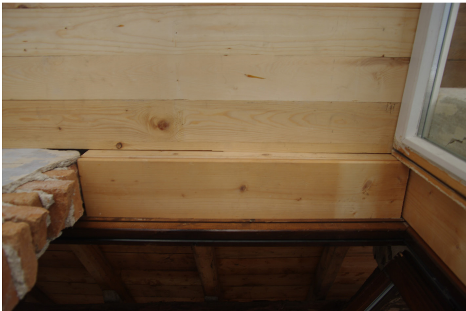
7.17: Dettaglio della chiusura del lato superiore
