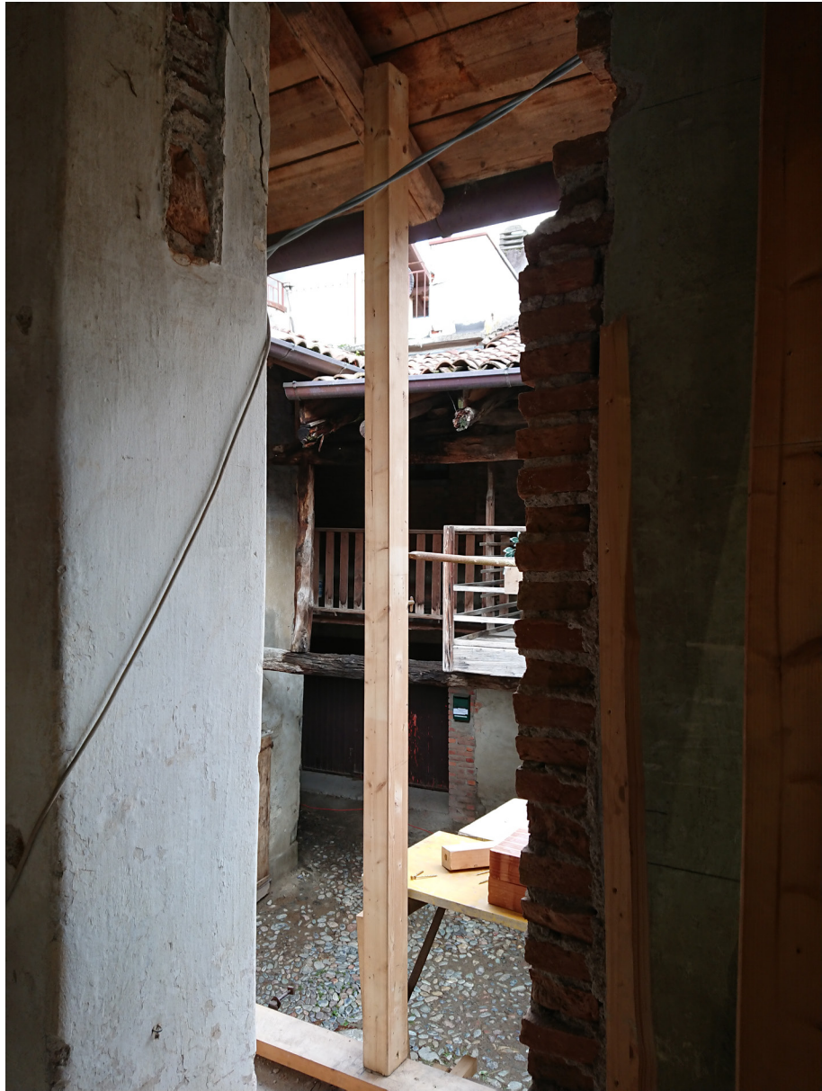
7.13: Prime prove di po- sizionamento del montante verticale
