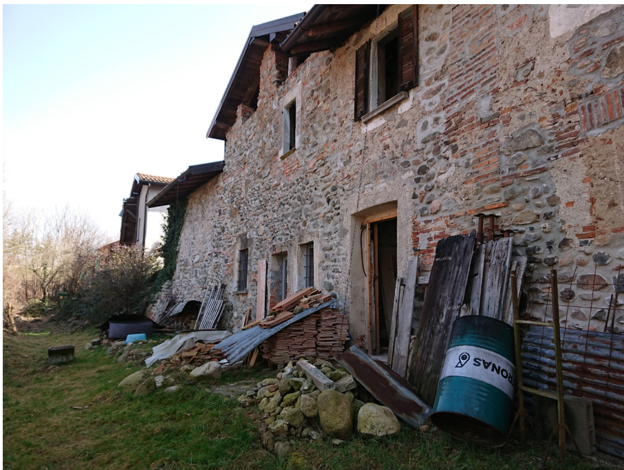
5.5: Muratura della facciata rivolta verso l'ex roggia
