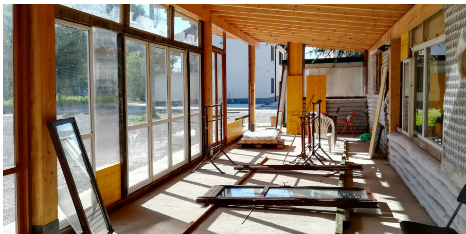
2.14: Foto del cantiere
