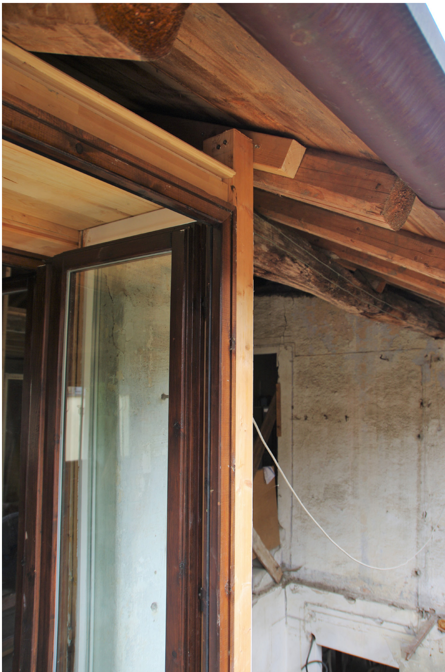
7.26: Dettaglio del nodo montante - corren- te - telaio
