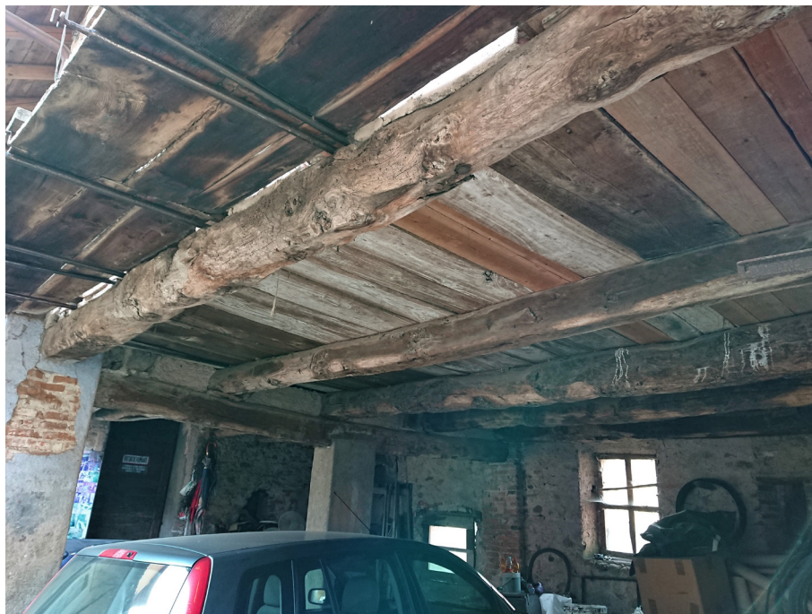
5.3: Il solaio inferiore della sala comune
