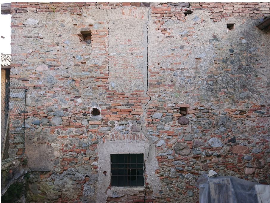
5.6: Muratura nel patio interno
