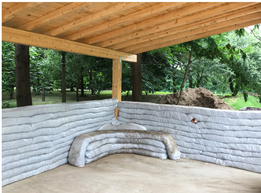
2.17: Muro in sacchi di terra
