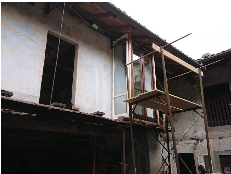
7.12: Prime prove di posizionamento dei serramenti
