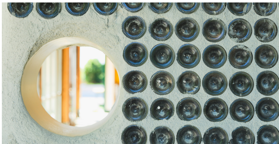
2.13: Dettaglio del muro di bottiglie riciclate
