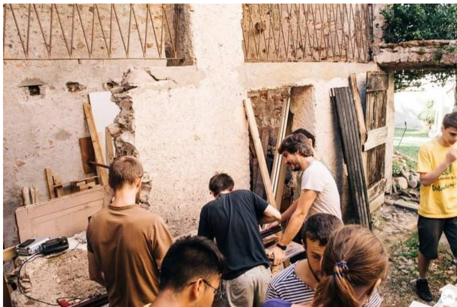
1.6: Lavori di rifaci- mento del solaio dell'ex legnaia
