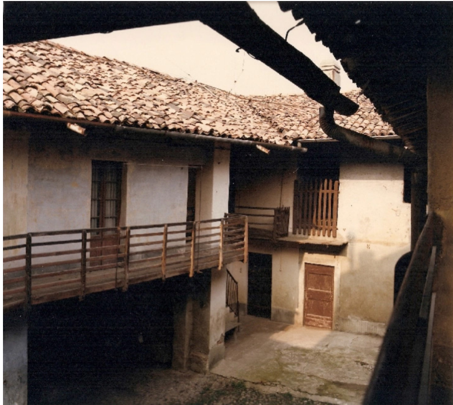
6.7: Foto storica della corte interna; è visibile il balcone prima degli inter- venti di rinforzo
