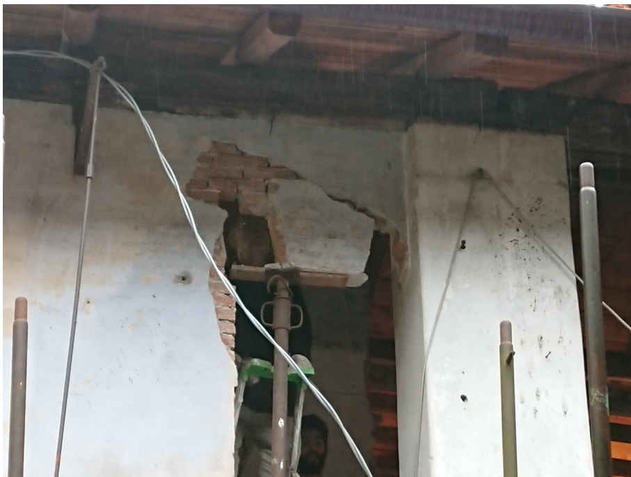
7.11: Demolizione por- zione di muro
