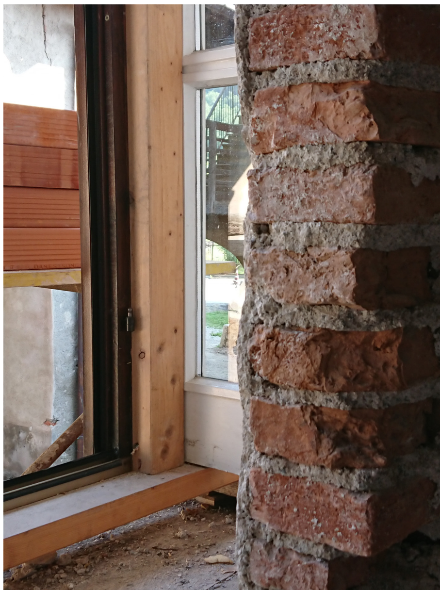
7.15: Relazioni tra ele- menti strutturali, serramenti e muro esistente
