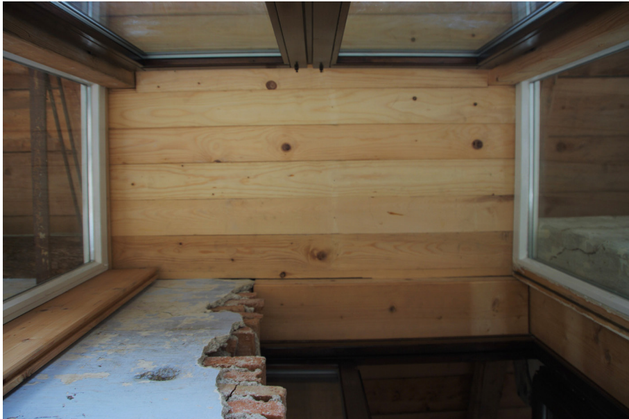
7.16: Posizionamento del tetto della serra
