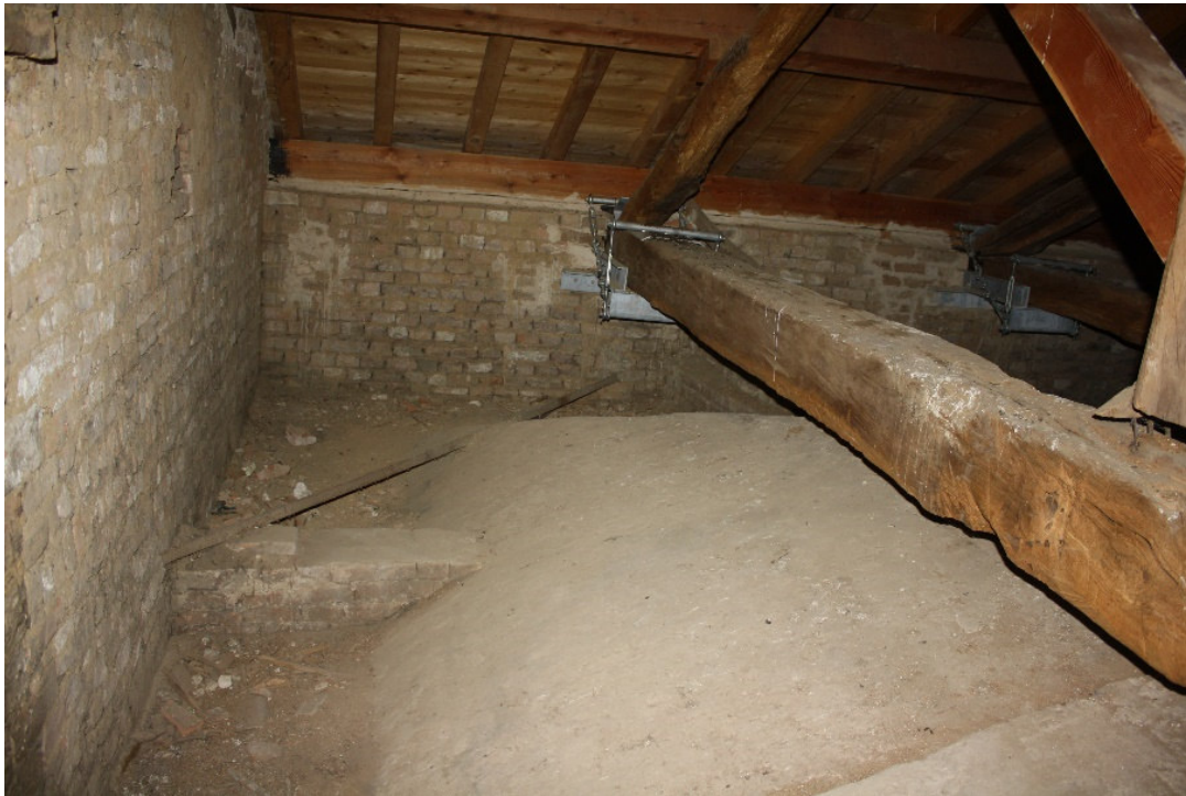
Figura 5-16: Fotografia di parte di una delle capriate del sistema strutturale del tetto
