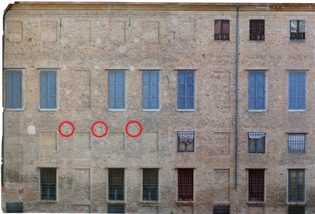
Figura 3-15: Fotopiano della parete ovest - cerchiati in rosso, i capochiave a livello del solaio
