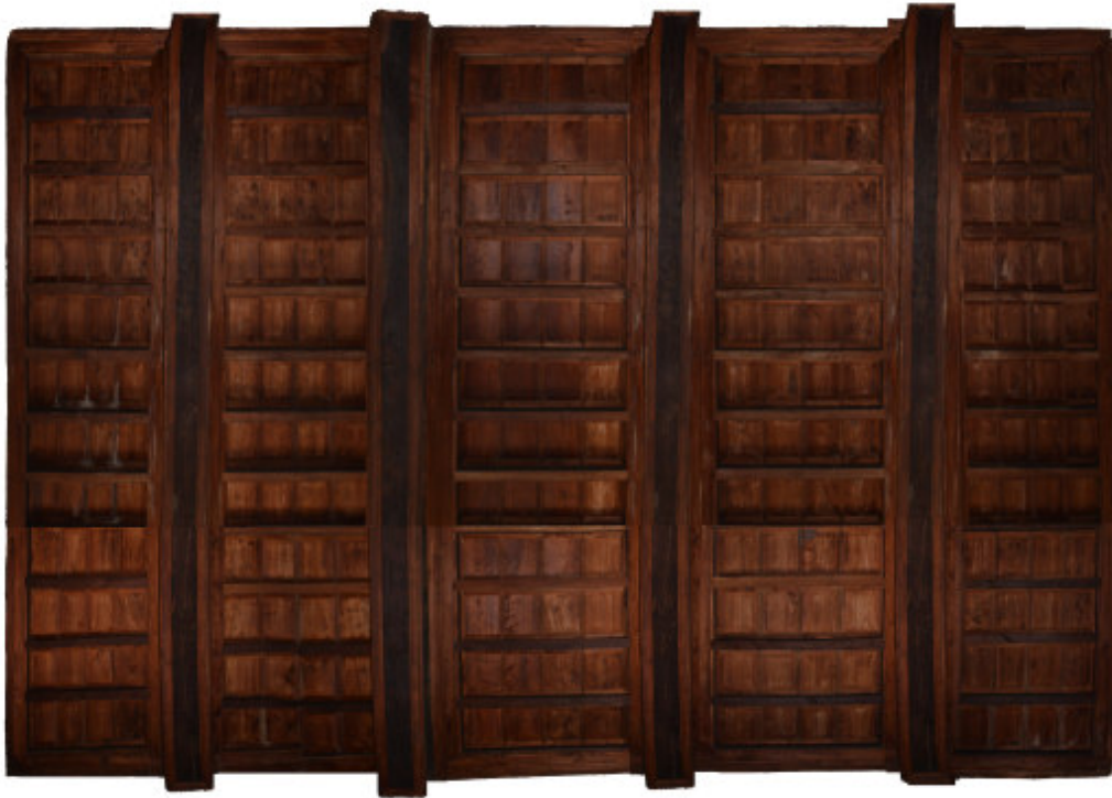
Figura 3-16: Fotopiano del solaio ligneo
