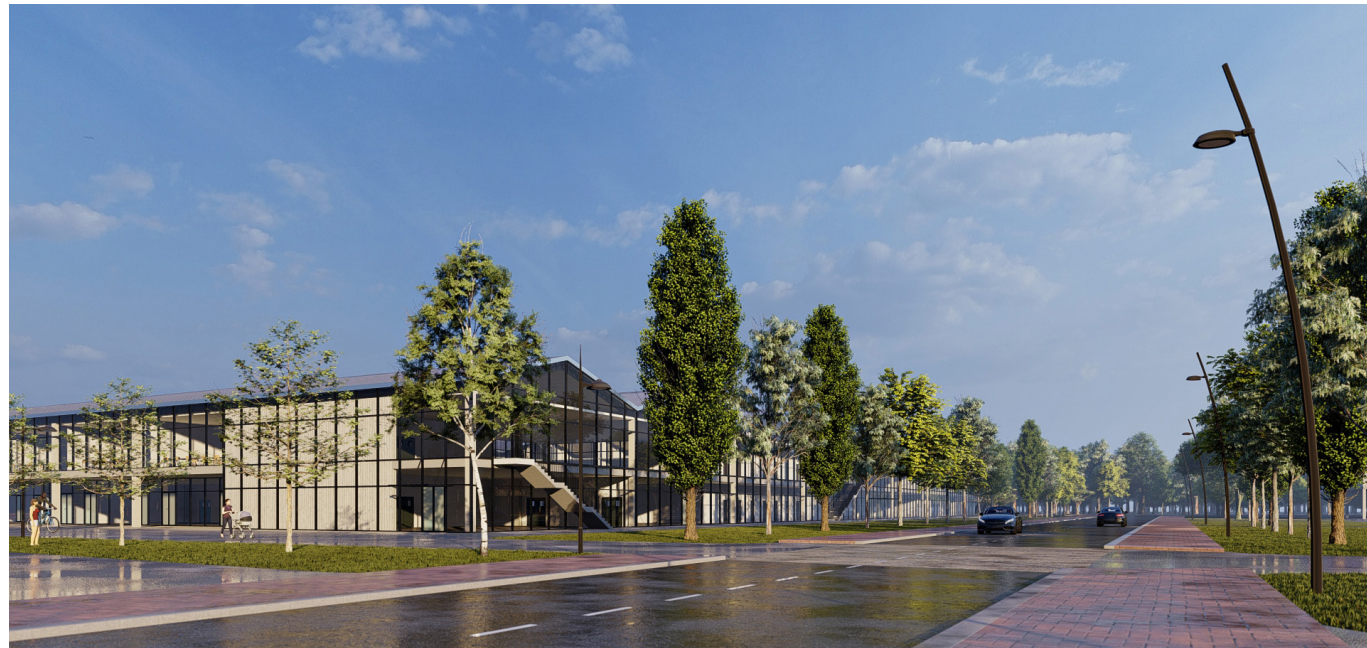
Vista esterna dell'edificio delle aule
