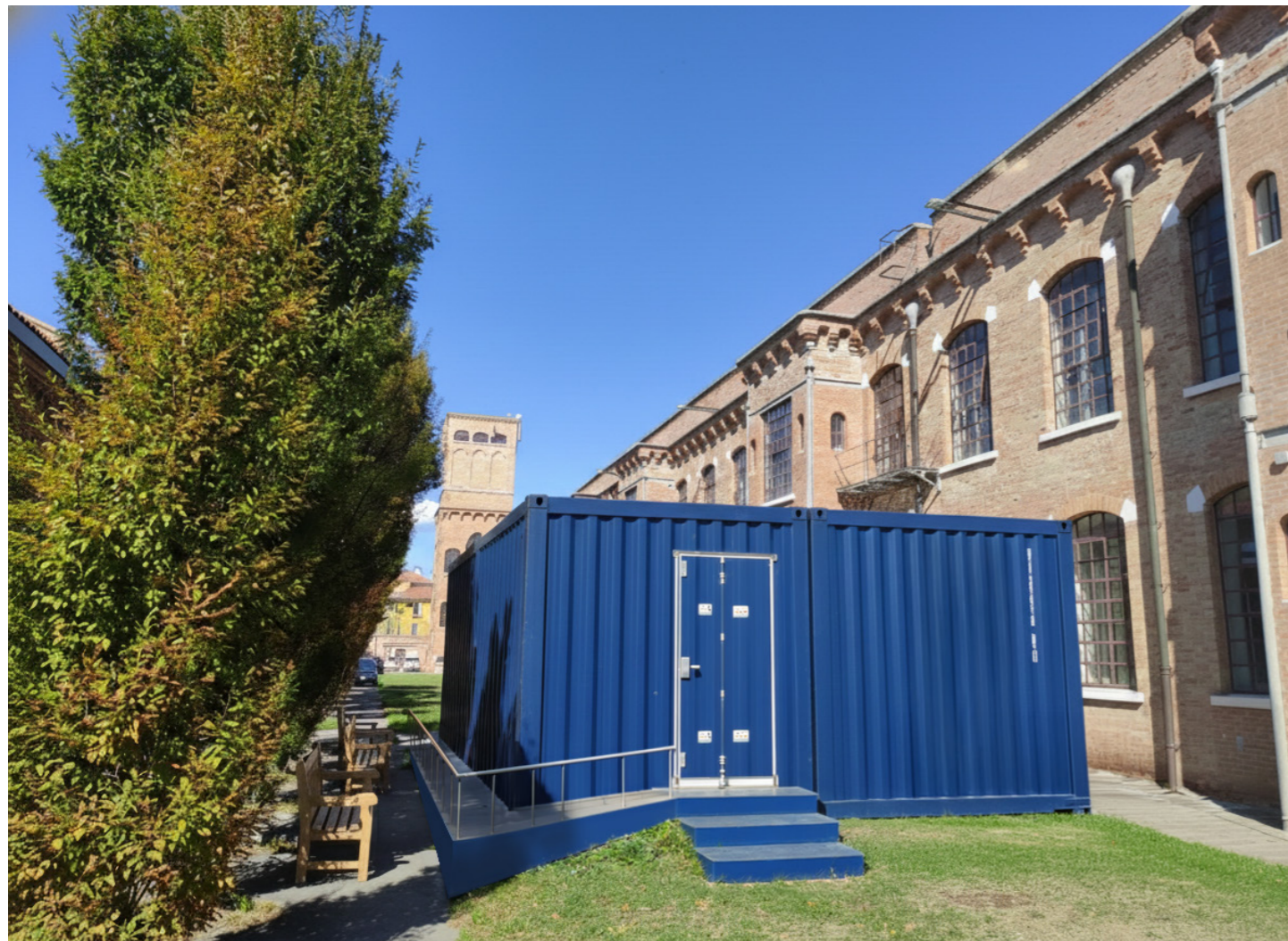
Vista frontale dell'installazione, atrio Ex Cotonificio della luav
