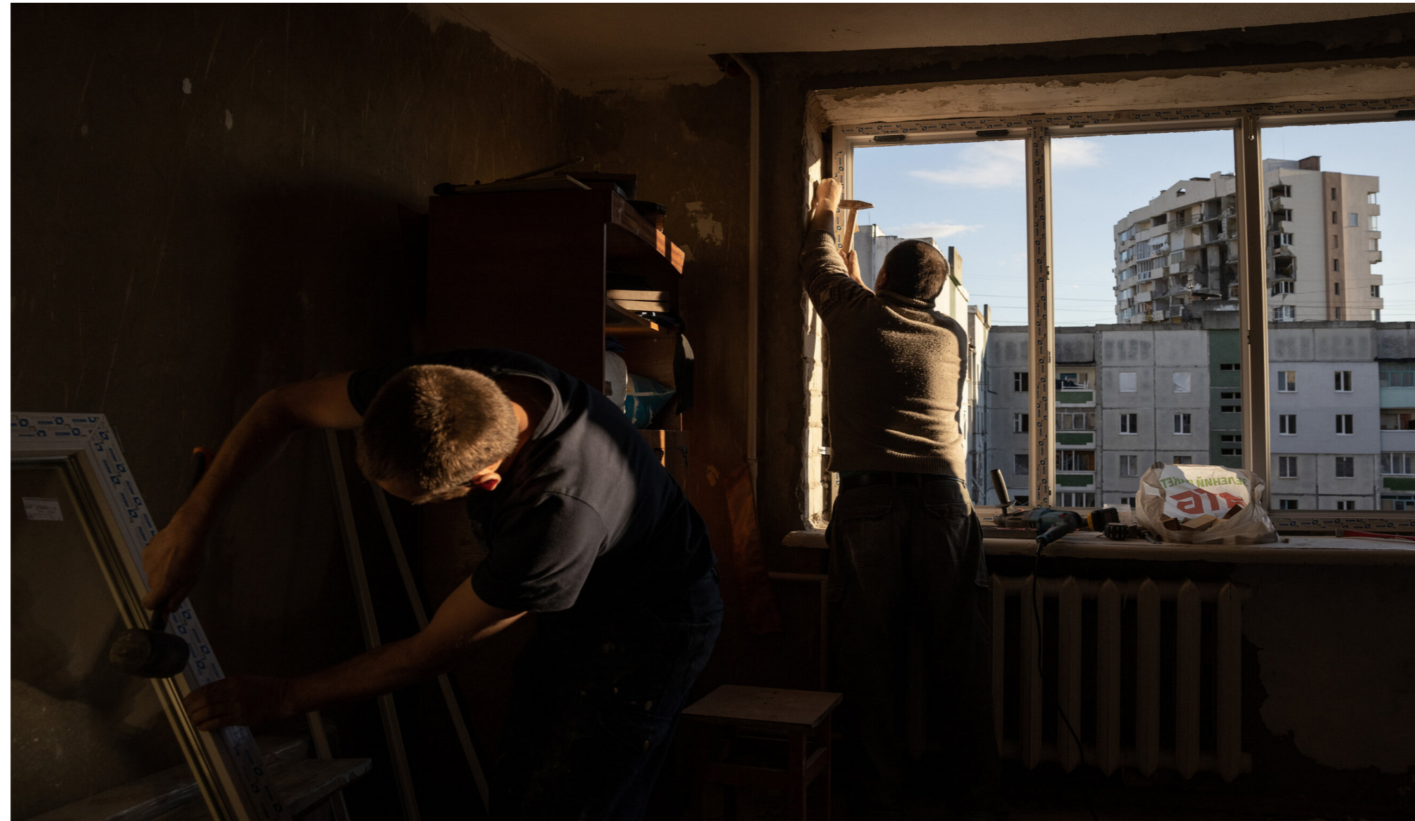
Figura 04.1: Jim Hylebroek, Operai installano nuove finestre per un complesso danneggiato Fonte: The New York Times
