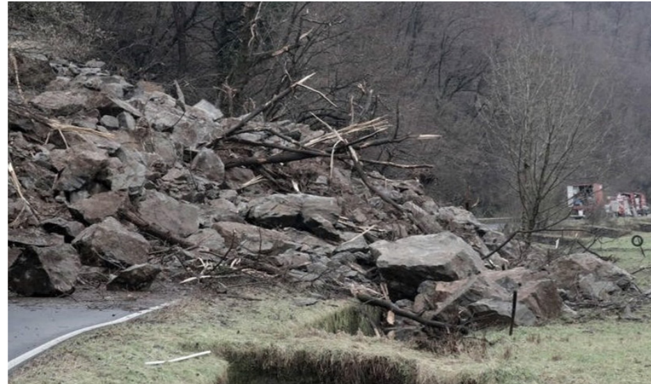
Figura 02.8: Gianatti, foto frana a Forcola sulla Provinciale
