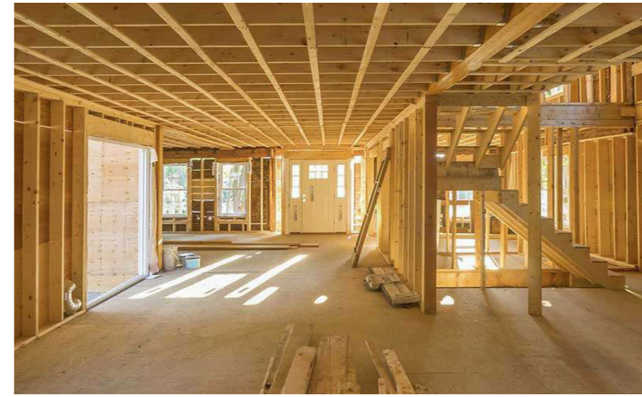
Figura 08.85: Pareti in timber frame Fonte: Ecohome
