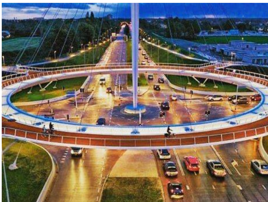
Figura 54 - Hovenring ad Eindhoven fonte: pinterest.ch
