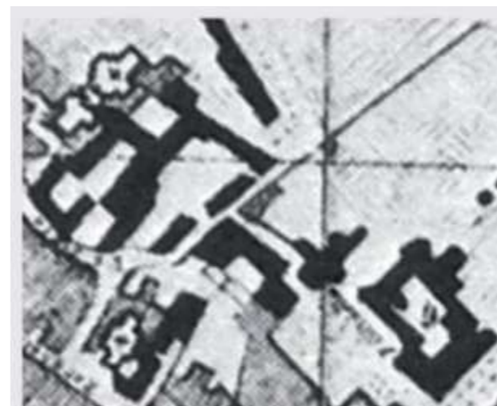
1881 Bracci nord-est Caserma Nicolai Demolizione cavalcavia
