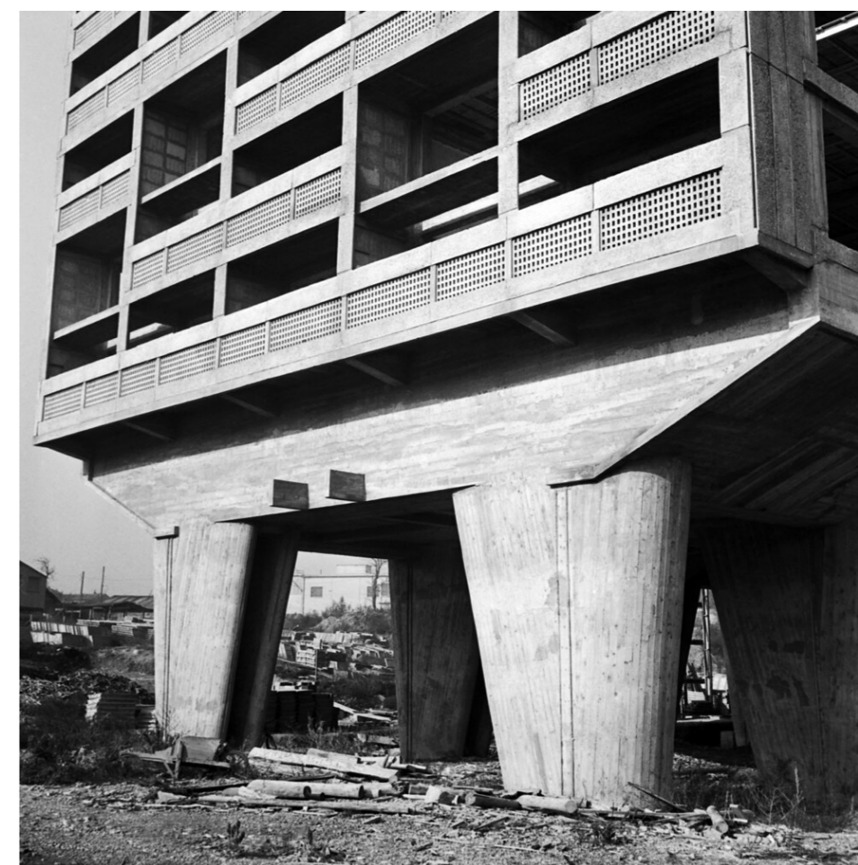
Fig 1.8 Dettaglio dei pilotis nella Unité d'Habitation de Marseille di Le Corbusier. Fonte: Flickr, https://www.flickr.com/photos/reconstruction1945-1979/21082329450 (ultima consultazione: gennaio 2026)
