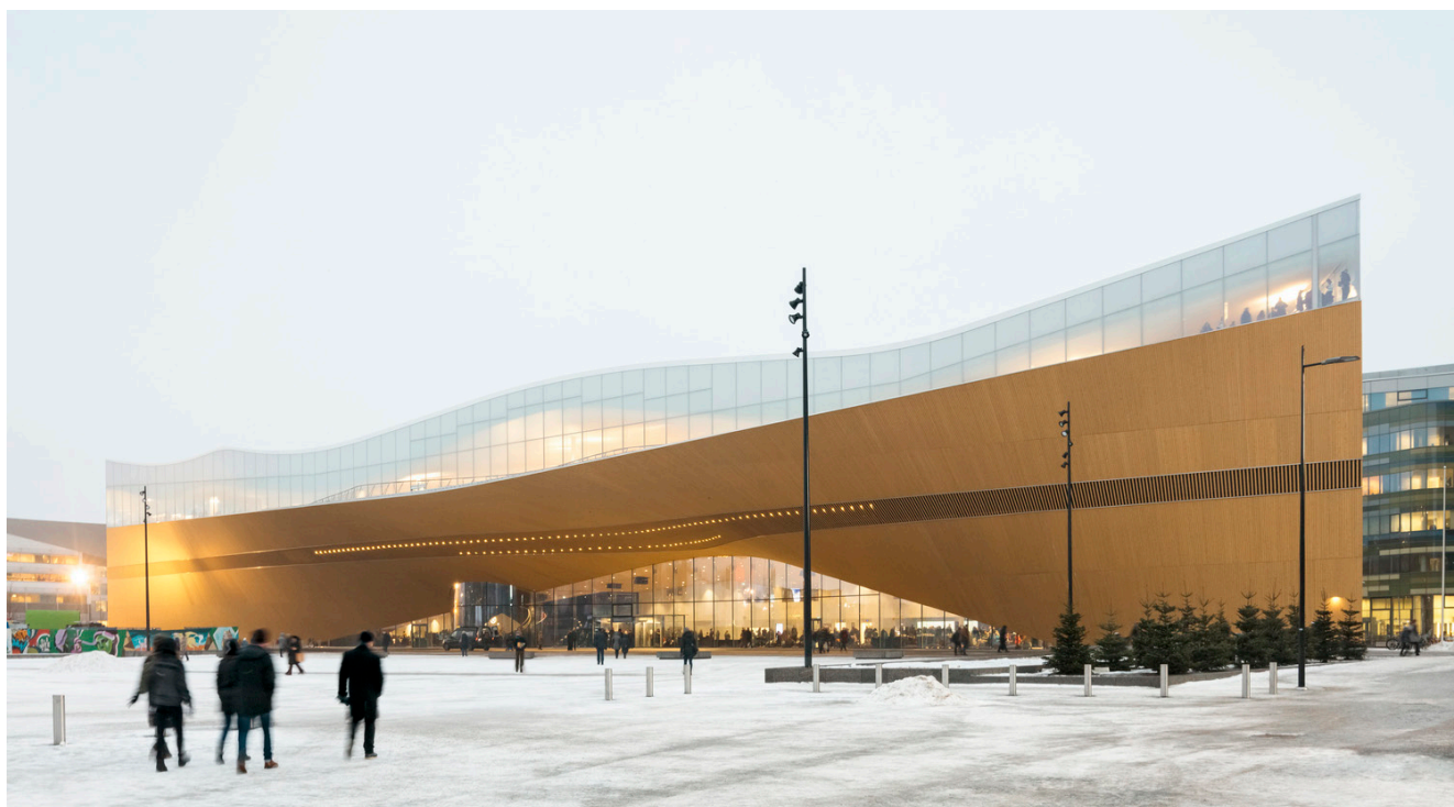
Fig. 2.28. Vista esterna © Tuomas Uusheimo
