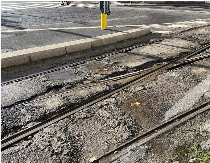
A62. criticità pavimentazione e binari del tram, linea 9 / fermata in Piazza Oberdan / reportage fotografico di Roberto Arsuffi per il blog Urbanlife / Settembre 2022
