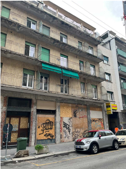
A87.via Achille Maiocchi, 10 / edificio residenziale-commerciale / attualmente in stato di riqualificazione
