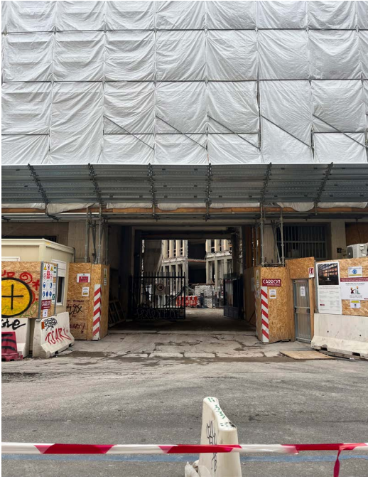
A86. via Achille Maiocchi, 4 / spazio residenziale-commerciale / attualmente in stato di riqualificazione
