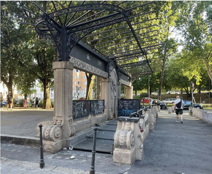
A61. Pensilina di ingresso dell'ex Albergo Diurno Venezia / Piazza Oberdan / reportage fotografico di Roberto Arsuffi per il blog Urbanlife / Settembre 2022
