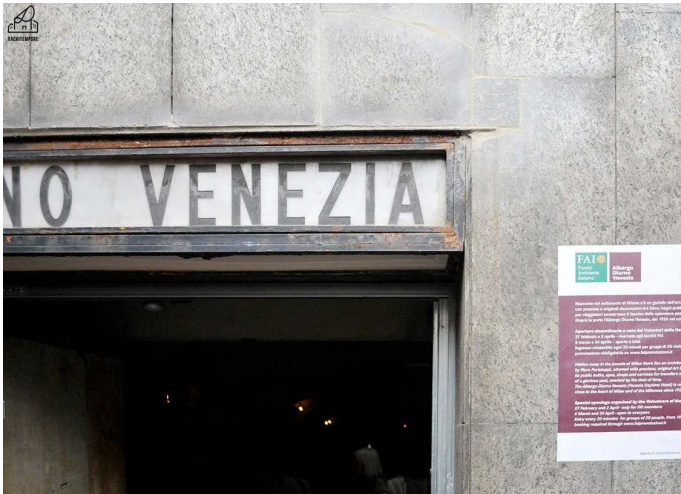
A72. ingresso attuale / dall'ingresso della M1 / intervento degli anni '60
