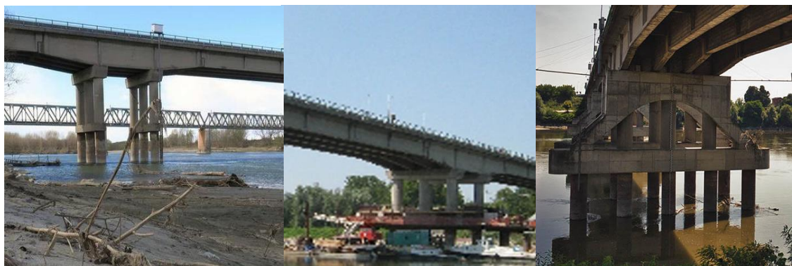
Figura 5.4 Pila originale; lavori in corso; pila rinforzata [16]
