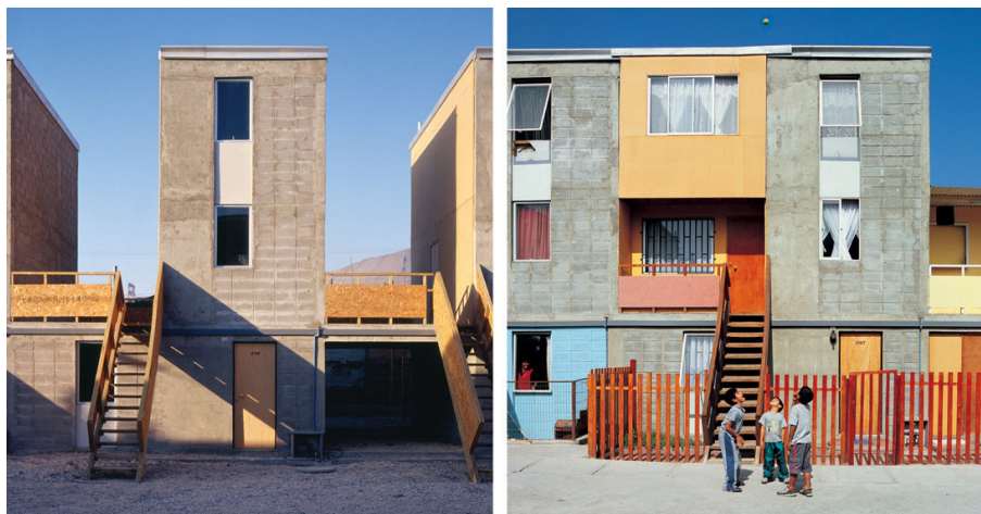
Immagine 32. Esempio di incremental design dello studio Elemental di Aravena. Scopo del progetto era quello di migliorare la qualità del social housing di Quinta Monroy in Cile, progettando con una porosità che permette cambiamenti nel tempo in funzione delle necessità.
