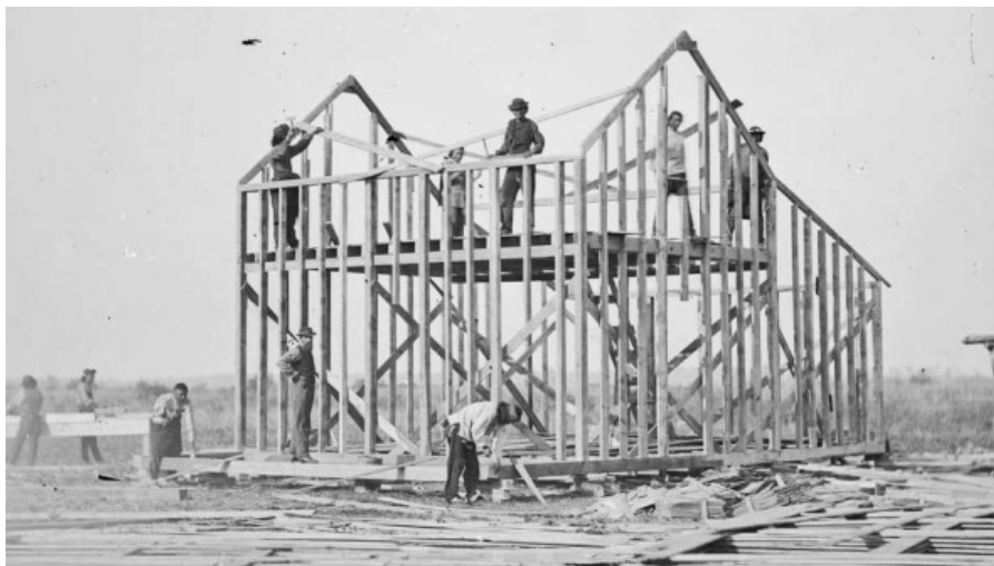
Immagine 19. Nel 1800 nasce il sistema costruttivo ad ossatura lignea noto come "balloon frame" (struttura a pallone) che permetteva ad un solo uomo munito di sega e martello di erigere la struttura di una casa a due livelli
