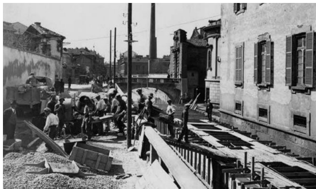
Fig. 4 e 5: Lavori di copertura del Naviglio Vallone nel 1929 (sinistra) e in via della Chiusa nel 1930 (destra).
