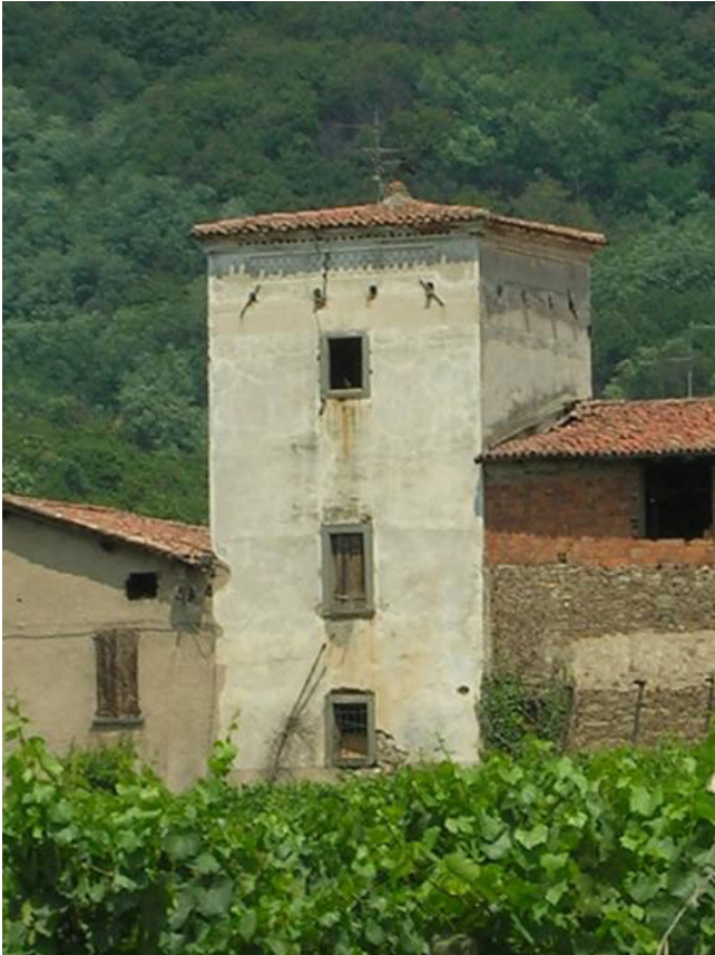
Fig. 29: Torre colombaia della cascina Badino (BS)
