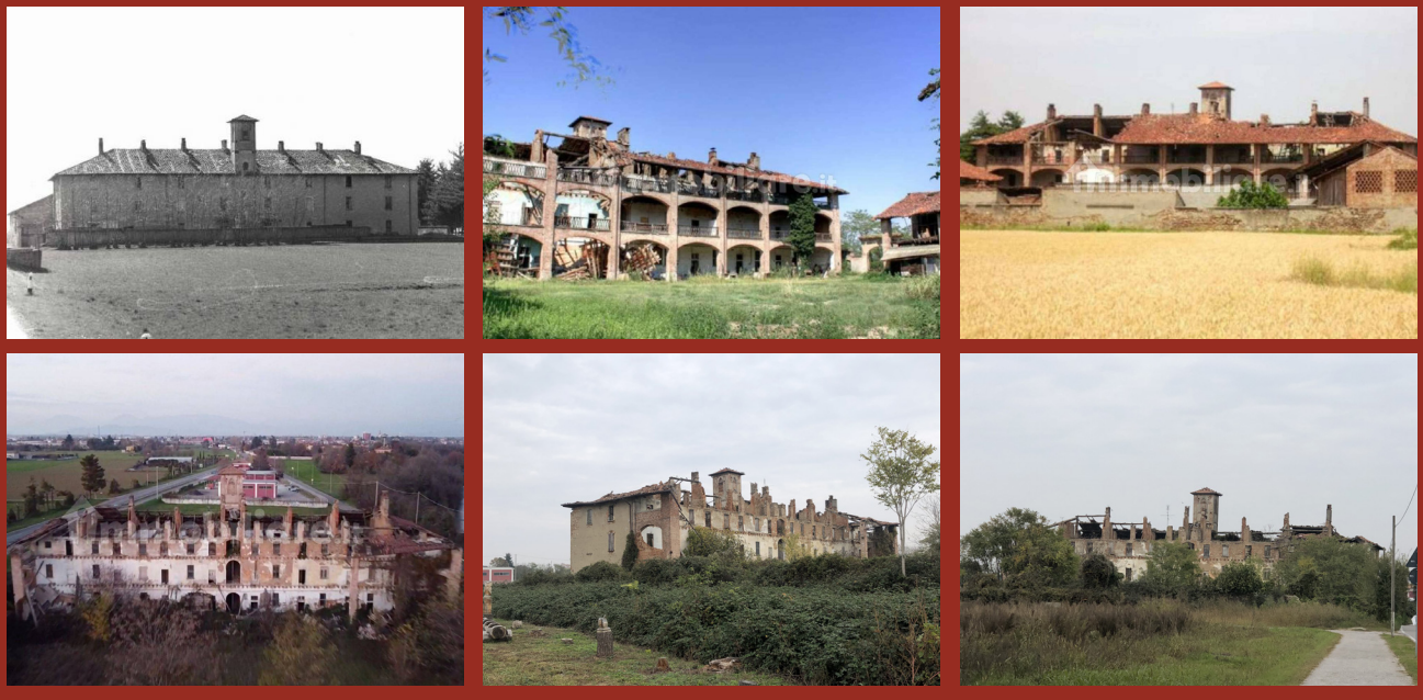
Fig. 88-93: Dalle fotografie si può notare il progressivo degrado subito dalla cascina, dalla sua interezza al crollo del tetto e degli edifici minori.
