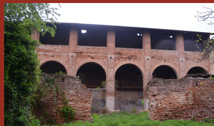
Fig. 76-81: Il rilievo fotografico svolto ha permesso di notare il peggioramento dello stato delle facciate: il rivestimento e il laterizio sono danneggiati e le aperture sono state quasi tutte murate.
