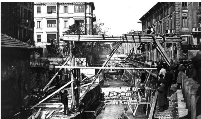
Fig. 10 e 11: La copertura della cerchia interna in via Senato, 1929.
