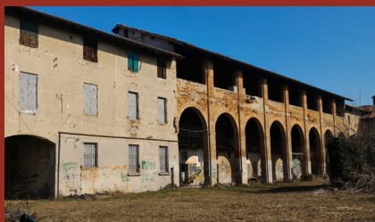
Fig. 76-81: Il rilievo fotografico svolto ha permesso di notare il peggioramento dello stato delle facciate: il rivestimento e il laterizio sono danneggiati e le aperture sono state quasi tutte murate.
