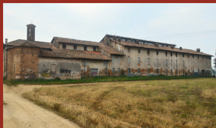
Fig. 76-81: Il rilievo fotografico svolto ha permesso di notare il peggioramento dello stato delle facciate: il rivestimento e il laterizio sono danneggiati e le aperture sono state quasi tutte murate.
