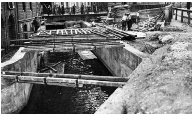
Fig. 8 e 9: Lavori di copertura del Naviglio di San Marco nella via omonima, 1935.
