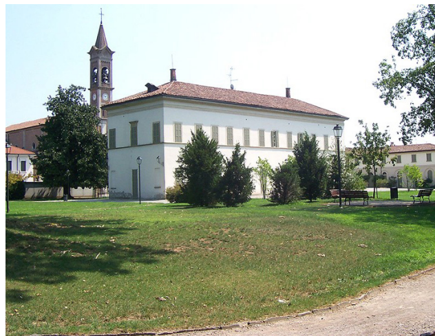
Fig. 19: Villa Daccò a Gessate
