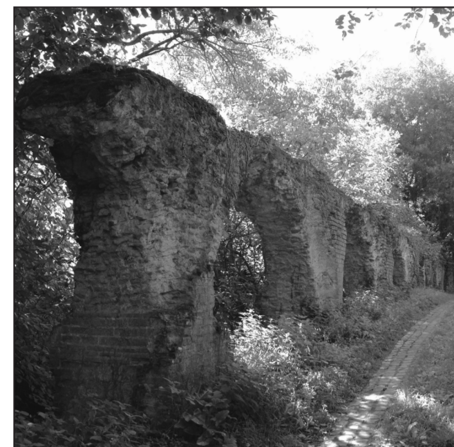
Tratto di acquedotto
