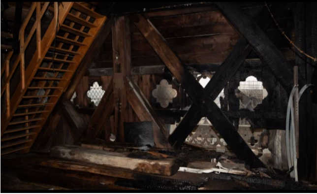
Figura 13 – L'interno della torre Nord [8]
