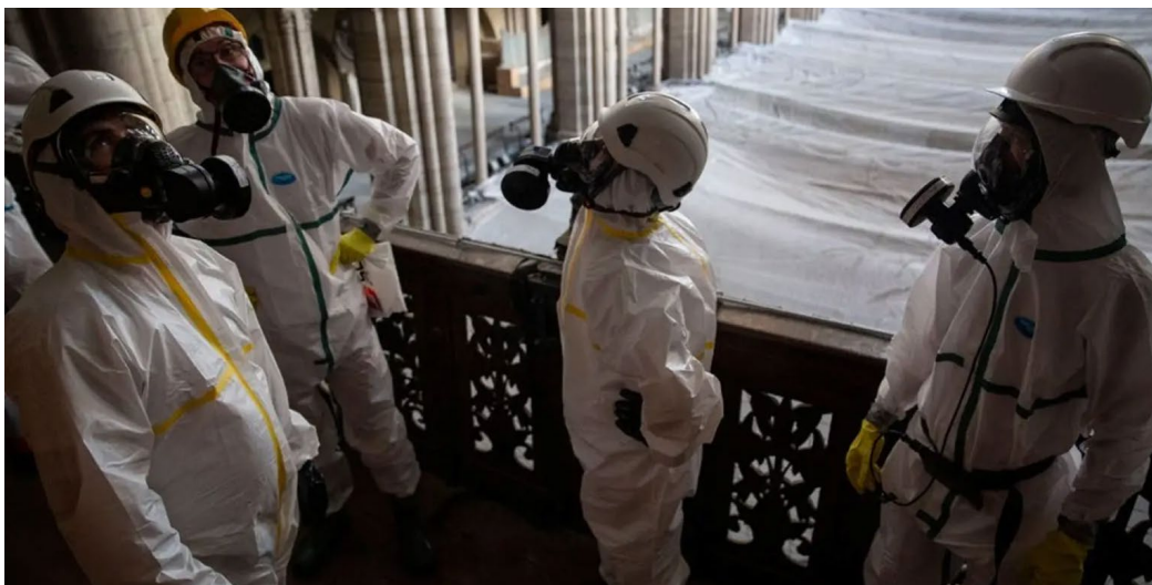
Figura 89 – Le operazioni di valutazione del danno [20]
