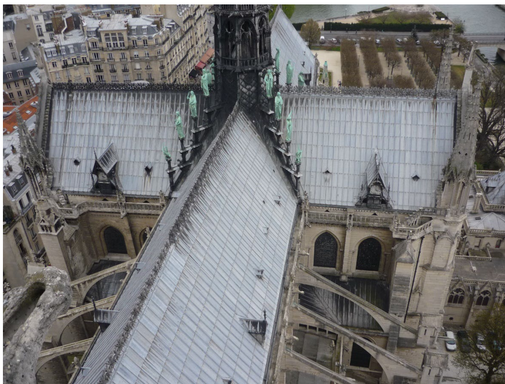
Figura 51 – Vista delle tegole di piombo presenti sulla copertura
