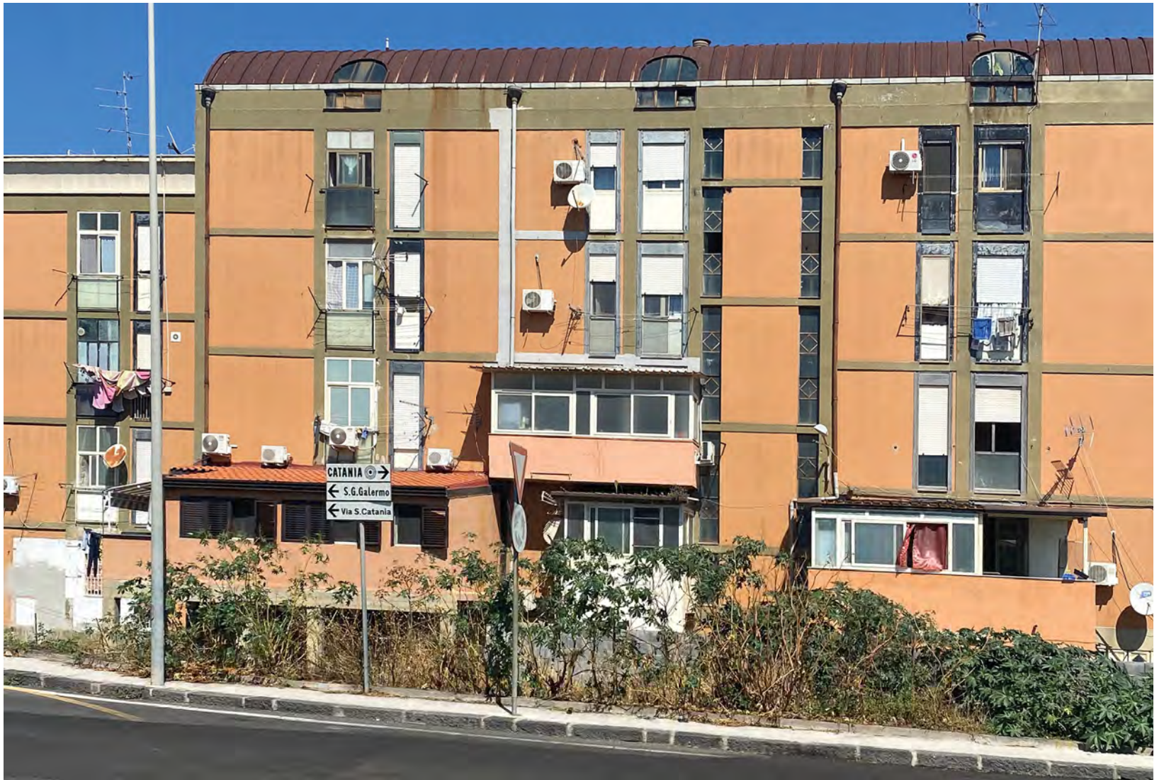
Fig. 35, Casa in linea affaccio su strada con superfetazioni.
