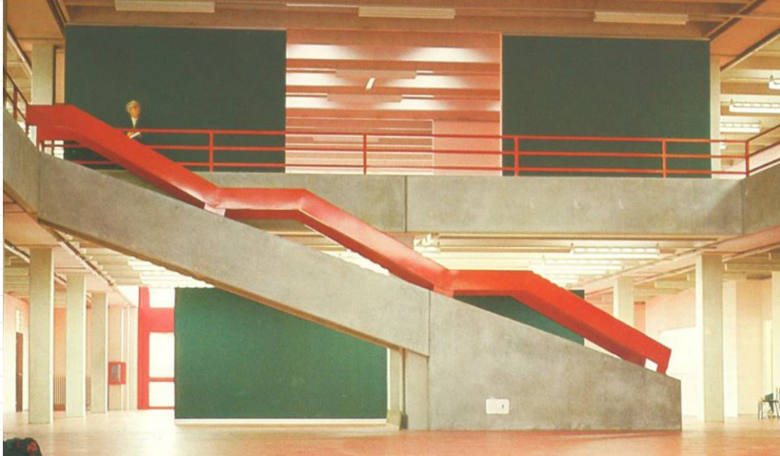
fig.45 foto interna scuola media chirignago in cui si evince il sistema della scala
