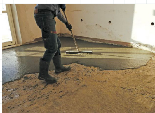
fig. 55 applicazione del microcalcestruzzo
