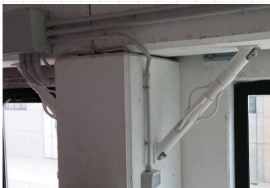
fig. 60 installazione del dispositivo antisismico EDIL TP
