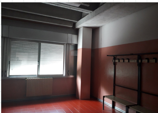
fig. 14 vista interna scuola Toscanini - spogliatoio tipo
