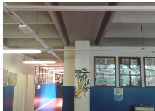
fig. 9 vista interna scuola Toscanini - corridoio
