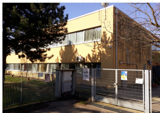
fig.12 vista esterna scuola media E.Salgari-accesso pedonale
