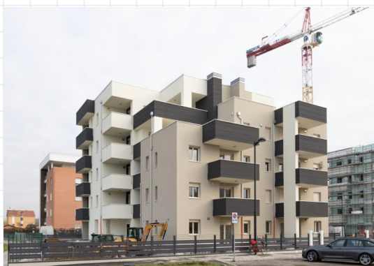
fig. 14 condominio a Castenaso (BO) isolato con Neopor
