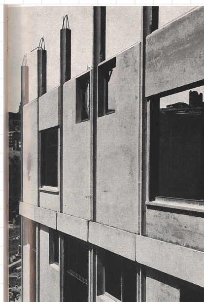
fig. 28 sistema costruttivo S.C.A.C S.p.A
