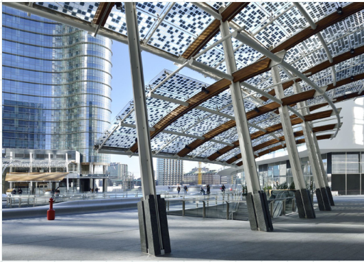
fig. 30 pensilina fotovoltaica piazza Gae Aulenti, Milano
