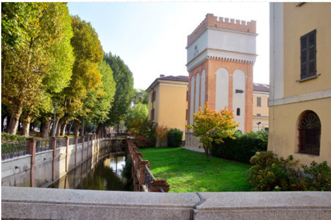
fig.11 Tratto della Roggia Castrina e torre dell'acquedotto
