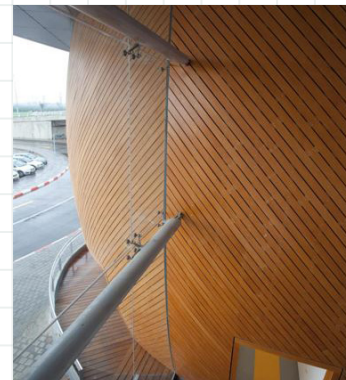
fig. 34 facciata continua con sistema a ragno e traverso arretrato (linguaggio 3)
