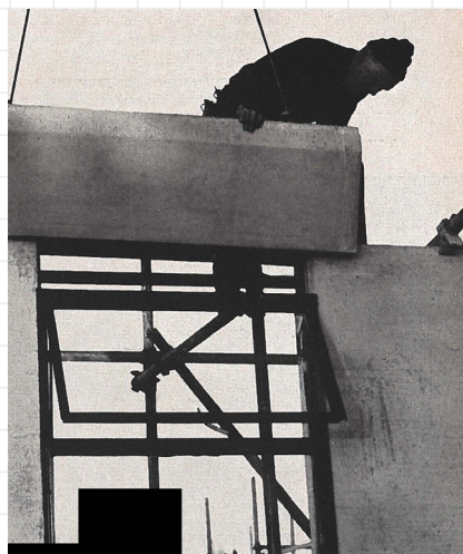
fig. 30 montaggio elementi di facciata
