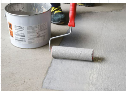
fig. 54 applicazione del connettore chimico
