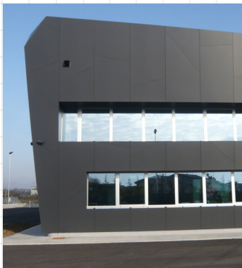
fig. 32 capnone industriale con pannelli di facciat e finestre a nastro (linguaggio 1)
