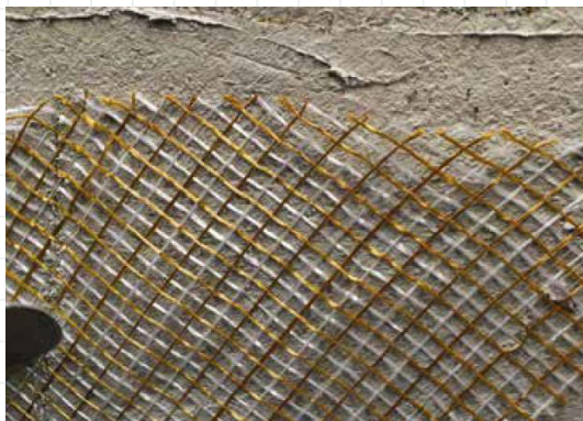
fig. 60 rete bidirezionale per il rinforzo antiribaltamento
