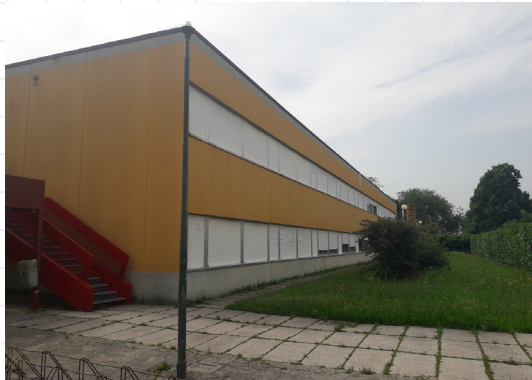
fig. 6 vista esterna del corpo aule
