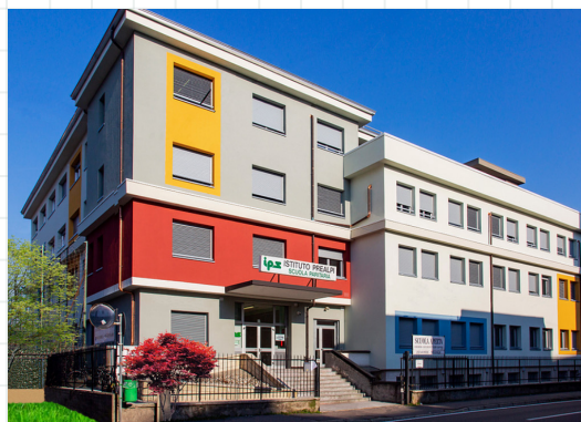
fig. 15 Istituto Prealpi di Saronno (VA) isolato con Neopor
