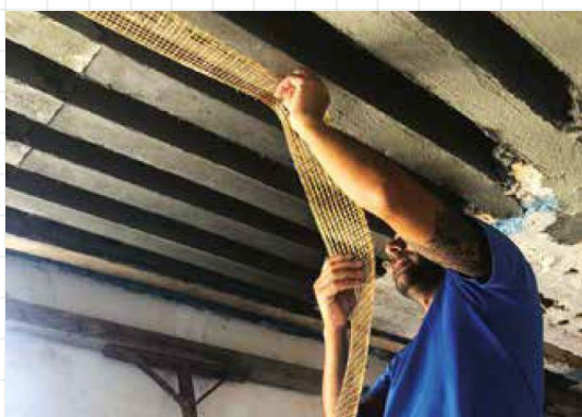
fig. 52 applicazione longitudinale del sistema FRCM
