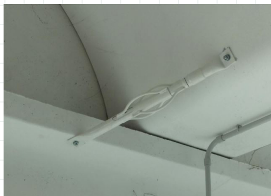
fig. 61 installazione del dispositivo antisismico EDIL TT
