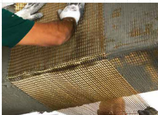
fig. 53 applicazione trasversale del sistema FRCM
