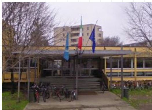
fig.25 vista esterna scuola media S. Morcelli
