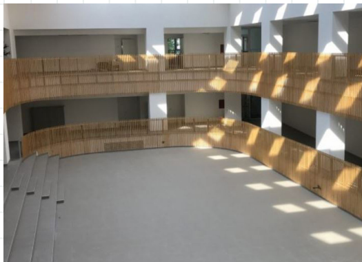
fig.23 vista interna Istituto Comprensivo Città di Chieri - edificio di ampliamento
