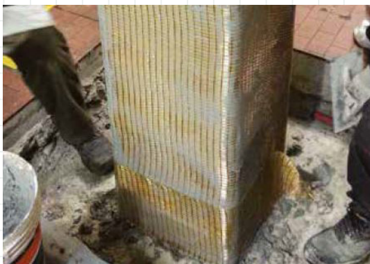
fig. 56 applicazione del sistema FRCM sui pilastri
