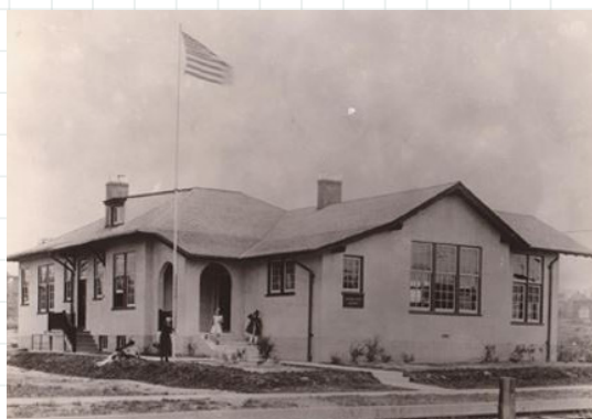
fig. 4 Prima Community School, eretta nel 1916 in DeMun Avenue a Clayton, costituito da un edificio di quattro stanze
