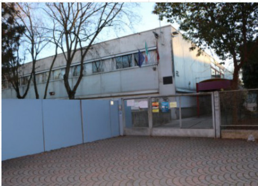
fig.5 vista esterna scuola media Di Vittorio
