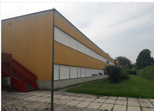
fig.24 vista esterna scuola media A. Toscanini
