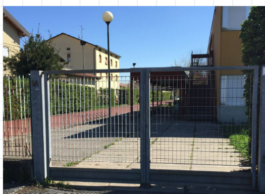
fig. 3 vista estern ingresso della scuola
