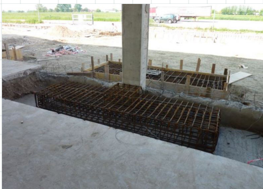
fig. 58 rinforzo delle fondazioni con ampliamento dei plinti
