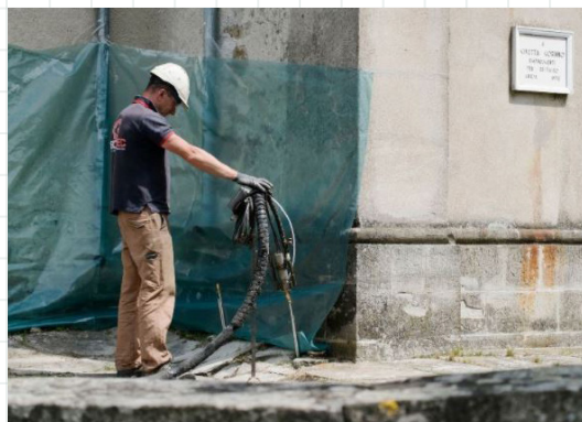
fig. 59 rinforzo del terreno tramite iniezioni cementizie
