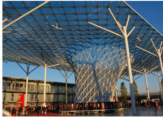
fig. 31 pilastri ad albero della copertura del polo fieristico Fieramilano, Rho
