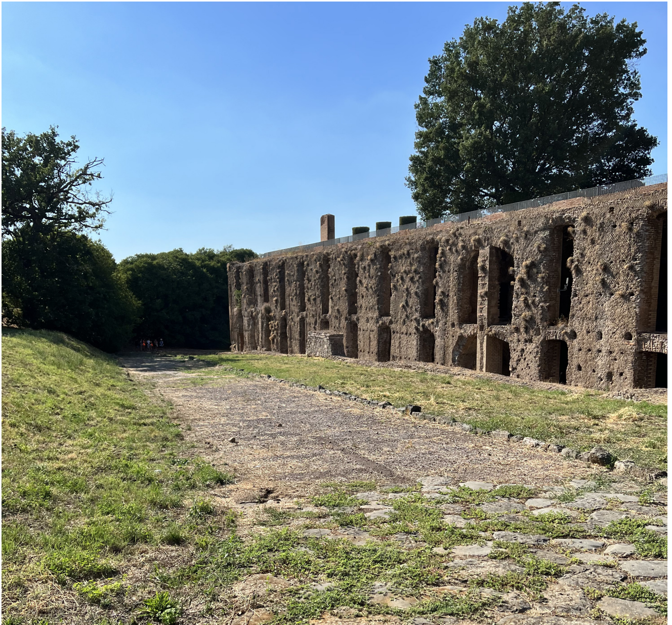
STRADA BASOLATA CHE COSTEGGIA LE CENTO CAMERELLE E CONDUCE ALL'INGRESSO MONUMENTALE
