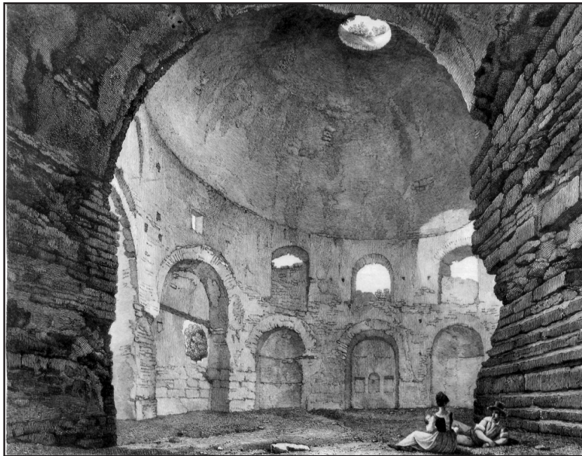
VEDUTA INTERNA DEL TEMPIO DELLA TOSSE A TIVOLI, A. TESTA
