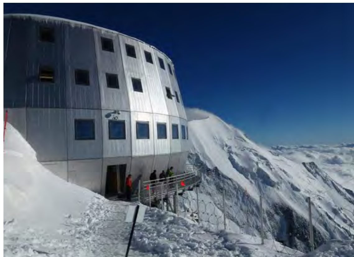
Fig.1.34 Refuge de Gouter sul monte Bianco 3867 m.slm ricostruito nel 2008.
