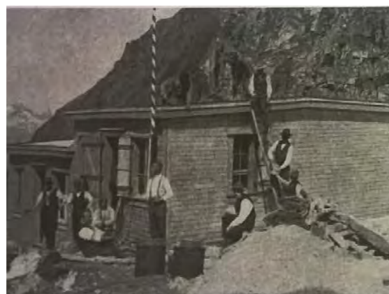
Fig.1.20 Le aperture irregolari, le finestre a nastro la copertura a falda singola della planurahutte.
