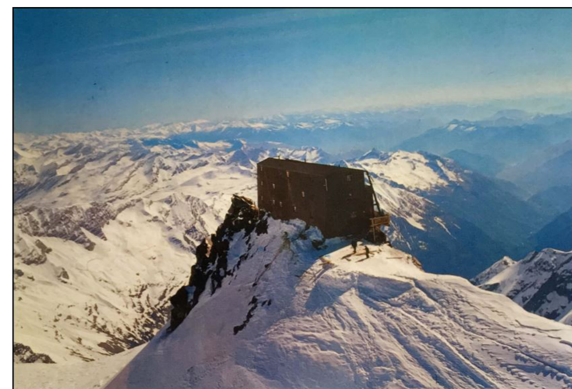
Fig.3.14 Fotografia storica del cantiere 1980 fronte nord-ovest.
