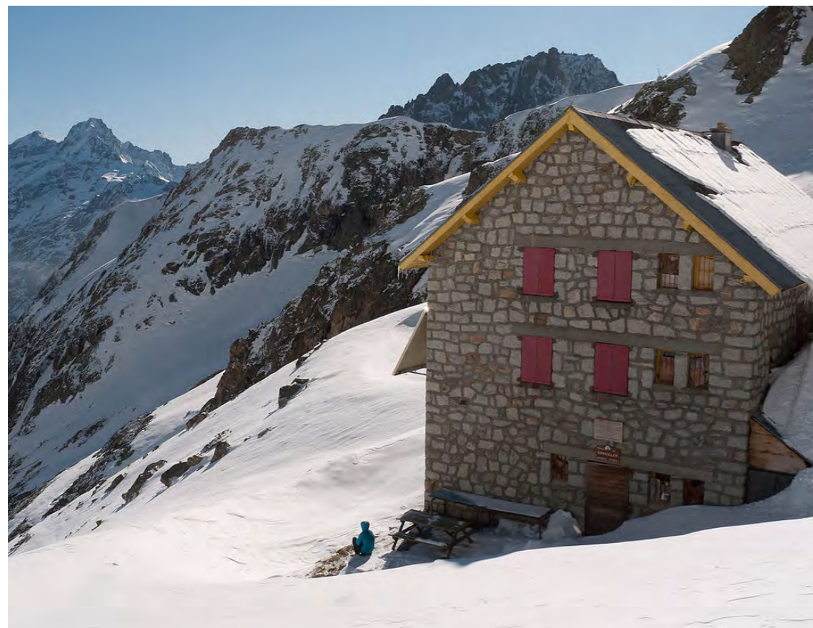
Fig.1.26 Rifugio Soreiller 2730m.slm il primo ad essere costruito tramite l’ausilio dell’elicottero nel 1957.
