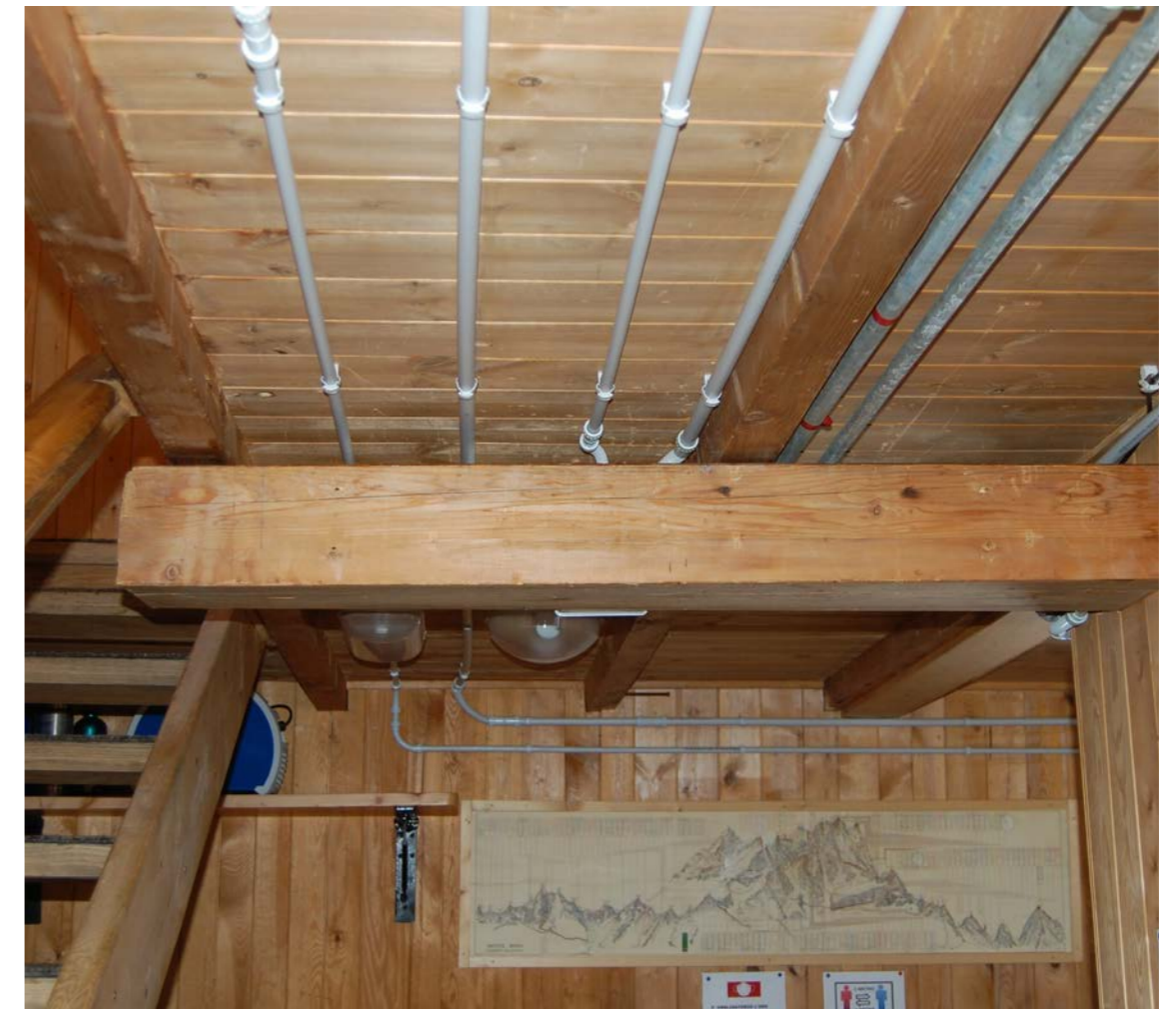
Fig. 6.11 Fotografia particolare costruttivo trave primaria travetti secondarie scala.
