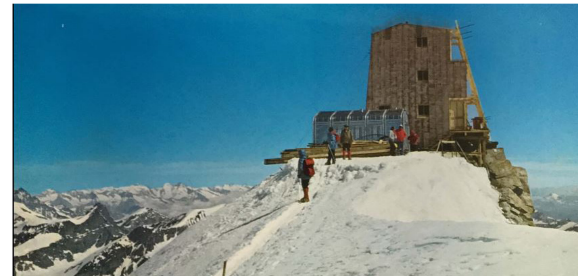
Fig.3.13 Fotografia del cantiere con i baraccamenti per fa dormire gli operai durante i lavori in quota.
