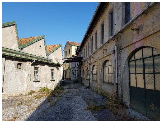
FIGURA 4.4 – Vista interna tra gli edifici della corte esterna ed i capannoni industriali
