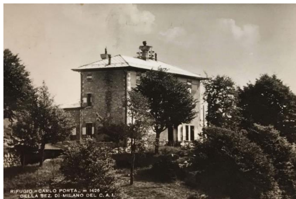
FIGURA 2.8 - Edificio storico voluto dal Cai Milano nel 1911, ubicato in una posizione strategica per le salite in Grignetta e per le più conosciute pareti d'arrampicata. La struttura, aperta tutto l'anno, conserva tutto il fascino e la bellezza delle strutture di inizio secolo
