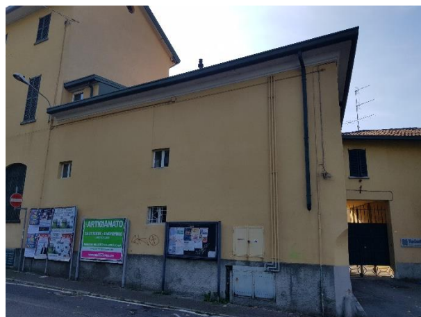
FIGURA 4.2 – Ingresso principale al lotto comunicante con via Alessandro Volta
