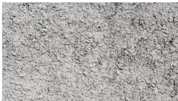
FIGURA 4.9 – Intonaco rustico
