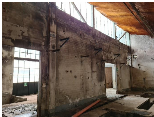
FIGURA 4.6 – Foto interna di uno dei capannoni industriali
