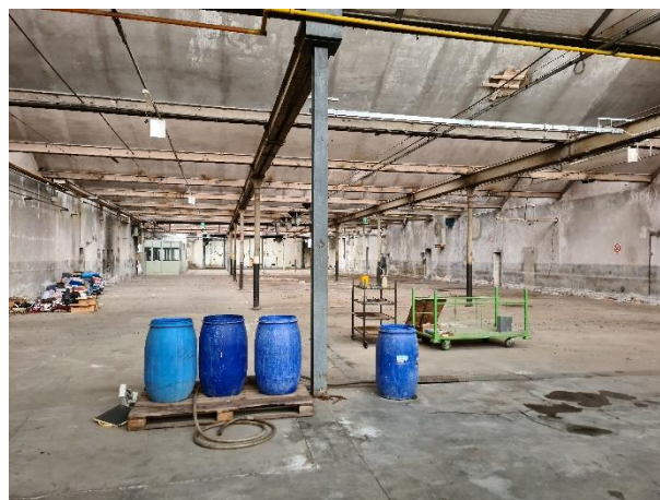
FIGURA 8.1 – Stato di fatto degli shed
