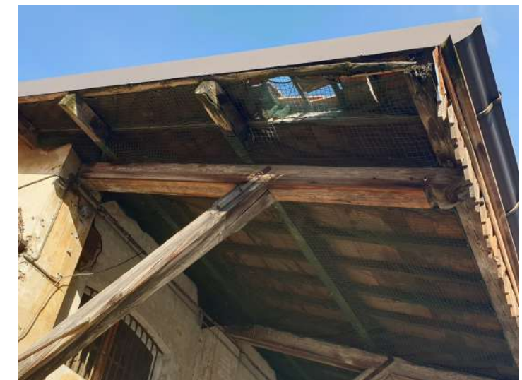
Fig.11.3.16, 11.3.17: Degradi nelle terzere e nel sottofondo in tavole laterizie (foto rilievo 6 ottobre 2020)
