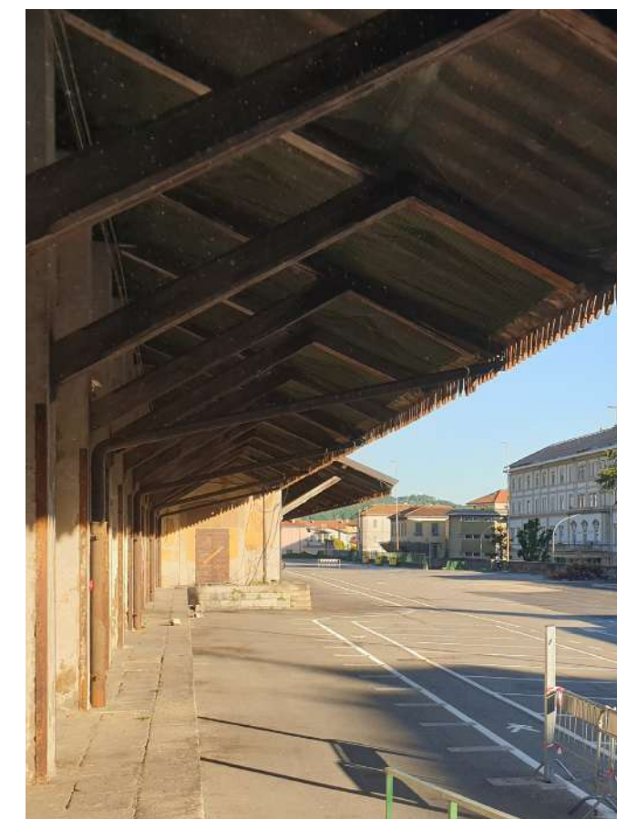
Fig. 8.4.6: Particolare del tetto alla Lombarda del magazzino ferroviario (foto rilievo 6 ottobre 2020)
