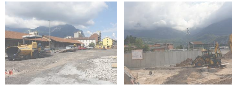
Fig. 6.1.19: Foto dei lavori in corso del 2021
