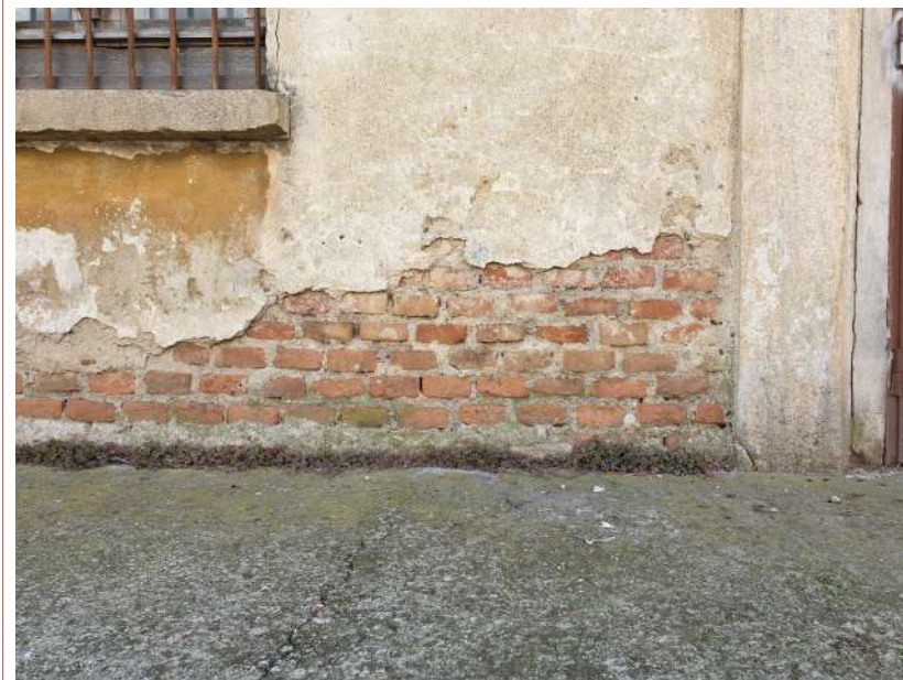
Fig. ST01.3: Muratura del magazzino
