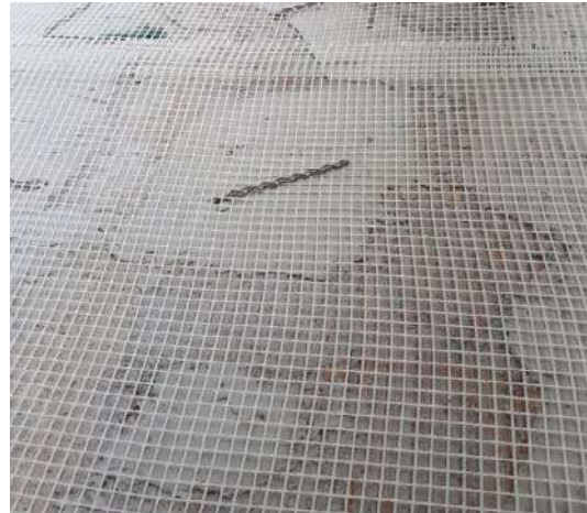
Fig. SI07.1: Armatura e rinforzi prima del getto di malta
