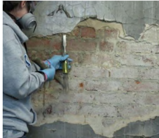
Fig. SI01.1: Asportazione dello strato esistente
