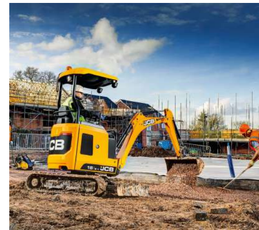
Fig. SI04.2: Escavazione del terreno
