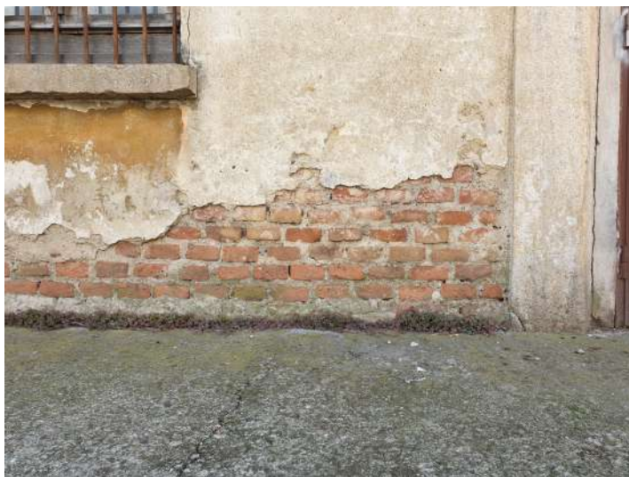
Fig.11.3.13, 11.3.14: Stato attuale della muratura (foto rilievo 14 settembre e 6 ottobre 2020)
