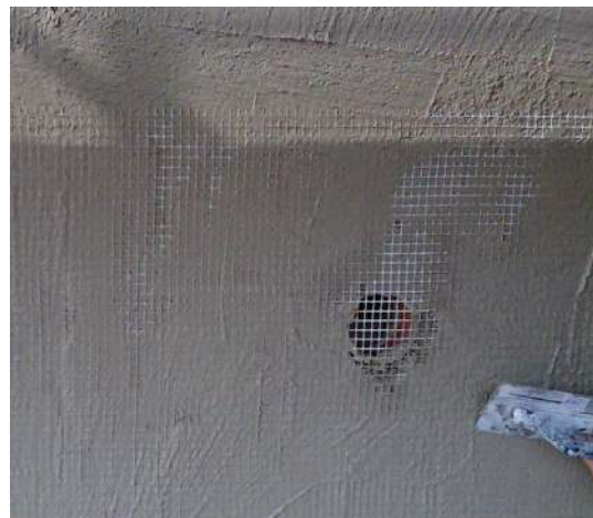
Fig. SI01.2: Rifacimento dell'intonaco esterno
