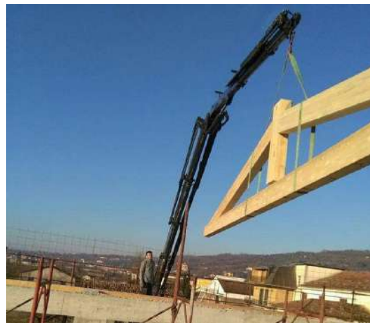
Fig. SI05.2: Posa in opera di una capriata
