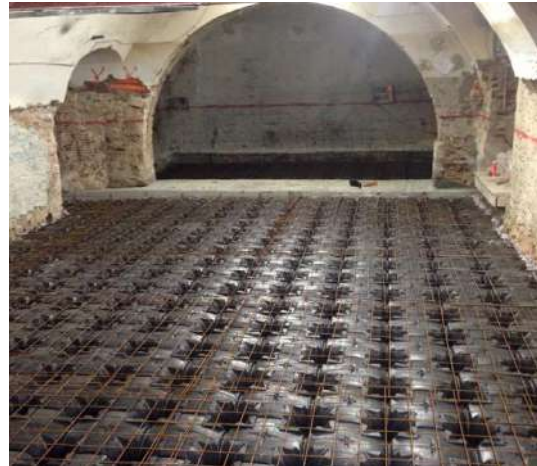
Fig. SI03.1: Realizzazione di un vespaio armato
