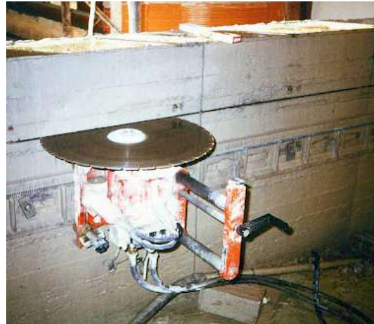
Fig. SI05.1: Taglio di muratura con lama diamantata
