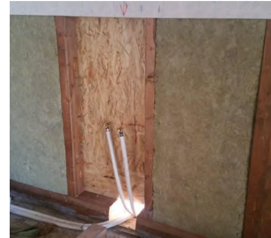
Fig. SI02.1: Sottostruttura lignea con isolamento fibroso
