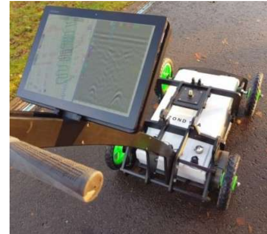
Fig. SI04.1: Esecuzione dell'indagine con georadar
