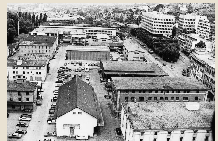
Fig. 4.1.7: Prima dell'intervento: edifici industriali abbandonati e degradati ( https://www.24heures.ch/vaud-regions/2010-emplématique-flon-lucernoises )
