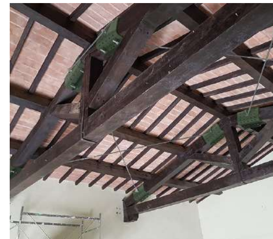
Fig. SI08.2: Consolidamento di capriate
