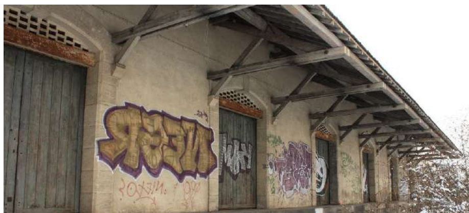
Fig. 8.4.15: Il magazzino di Vendevre, prospetto lungo (www.photos-ferroviaires.fr, 2009)
