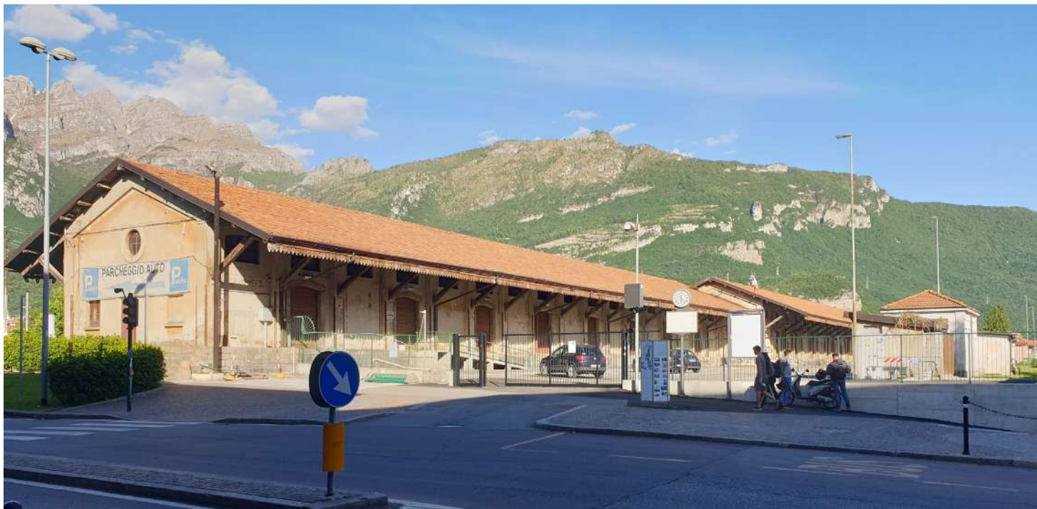
Fig. 11.2.1: L'edificio principale oggetto di studio; l'ex-magazzino merci dell'area La Piccola
