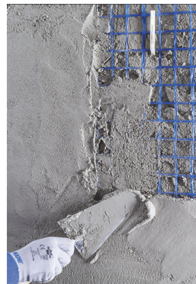
Fig.11.8.22: Esecuzione di un getto in malta cementizia armata con rete in fibra di vetro (FRCM)
