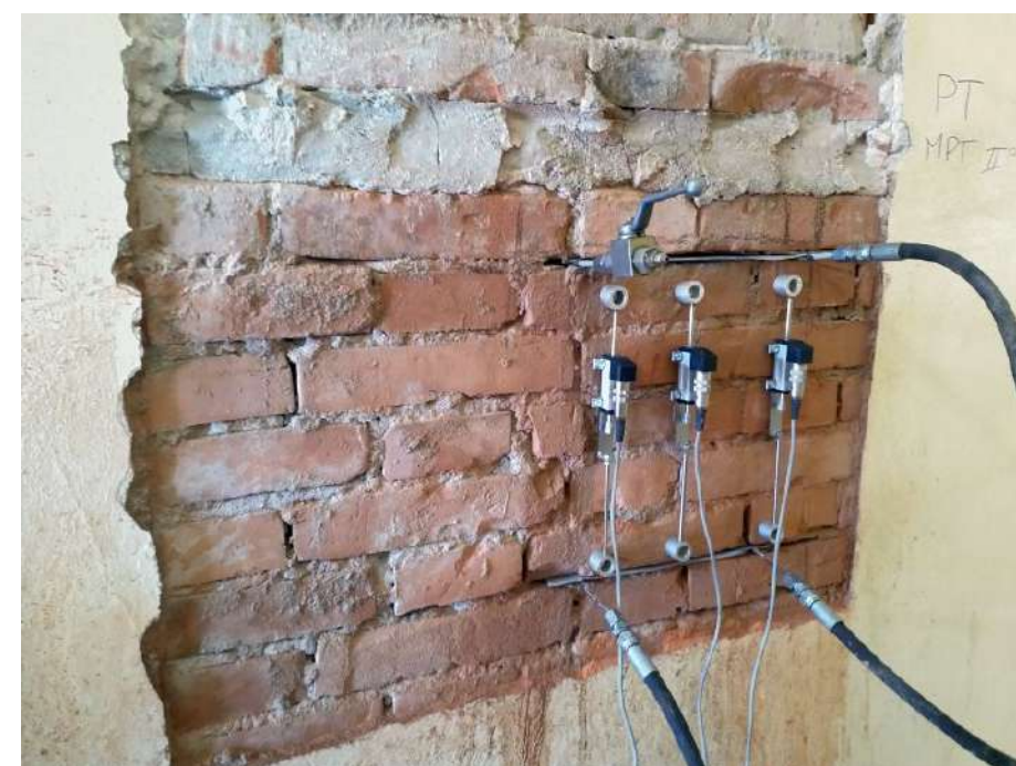
Fig. 11.4.3: Martinetti doppi (https://www.structuralsurveys.it/indagini-su-strutture-in-muratura-martinetti-piatti/)
