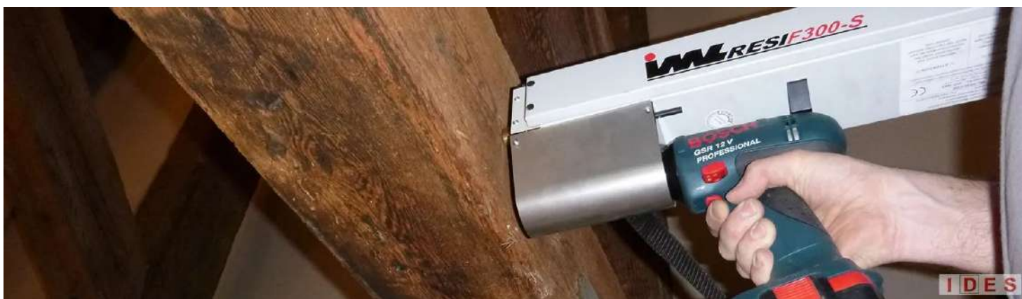
Fig. 11.4.14: Esecuzione di una prova resistografica su un elemento in legno ( https://www.indagini-diagnostiche.it/prove-materiali/prove-legno/ )
