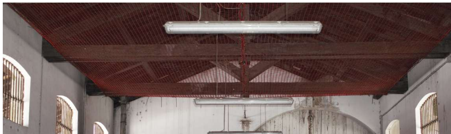
Fig.11.3.19: Stato attuale delle capriate (foto rilievo 6 ottobre 2020, particolare)
