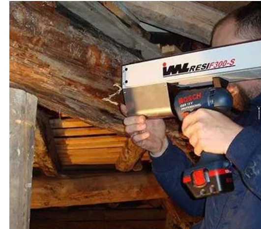
Fig. SI06.1: Esecuzione di una prova resistografica su un elemento ligneo di capriata
