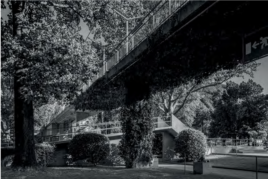
Figura 62 - Passerella Bellinzona | Fonte: www.spazium.ch
