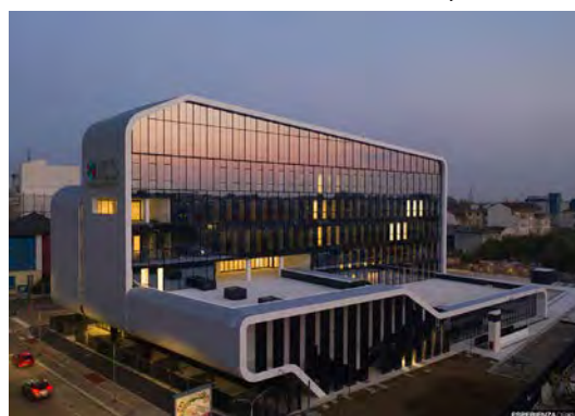
Figura 34 - Render ICS, in costruzione | Fonte: www.barrecaelavarra.it
