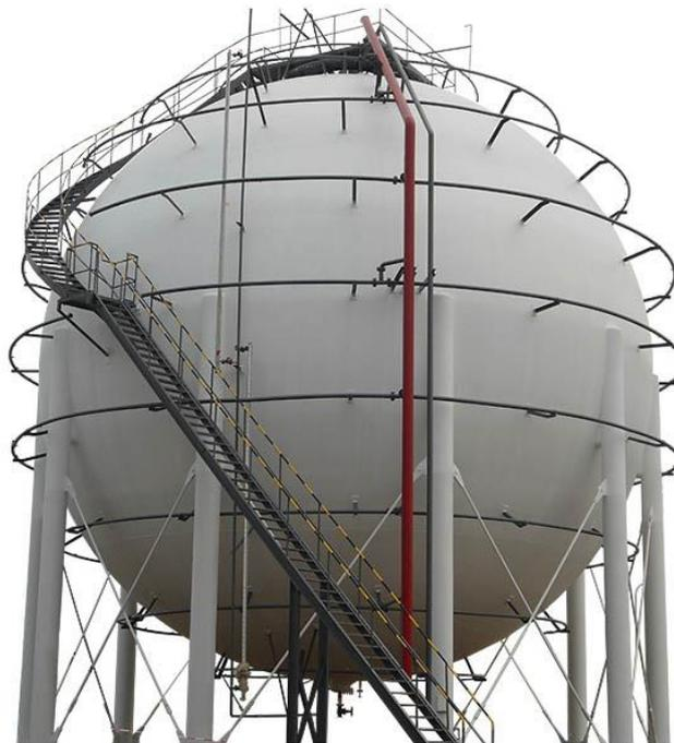
*Figura 3.24\_27: Serbatoio sferico di 6000 m3 contenente GPL*
