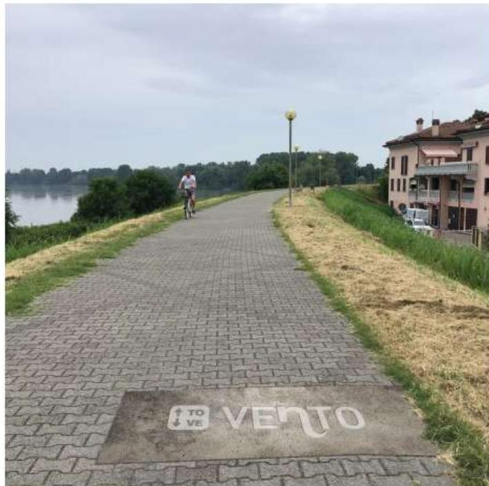
Figura 5.29 – Lastra in cls per la segnaletica di conferma su pavimentazione in cui non sarebbe efficace l'applicazione della vernice, da progetto MATE
