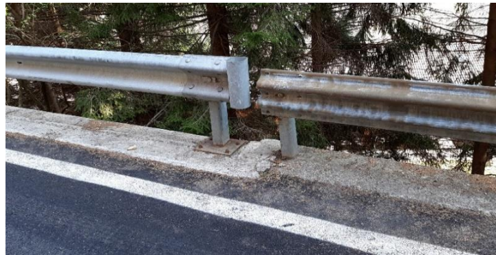
Figura 35 Assenza di transizione
