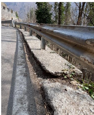
Figura 30 a) cordolo rotto b) perdita del vincolo d'incastro del montante nel cordolo
