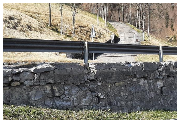
Figura 30 a) cordolo rotto b) perdita del vincolo d'incastro del montante nel cordolo
