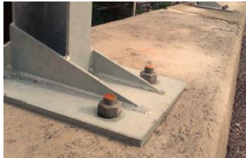
Figura 29 Esempio suola mal progettata
