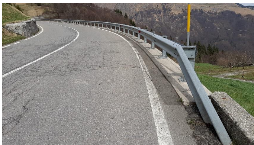
Figura 19 Barriera di sicurezza realizzata in acciaio zincato
