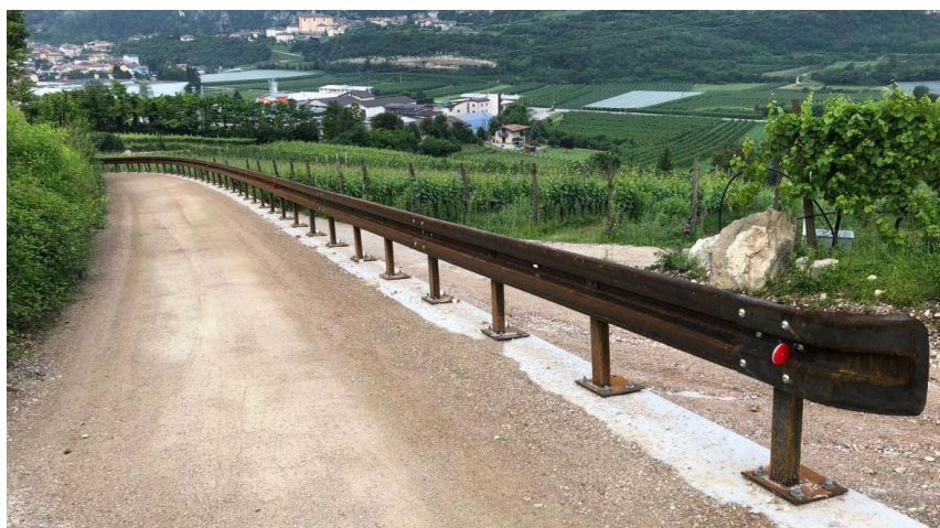
Figura 18 Barriera di sicurezza realizzata in Cor-Ten
