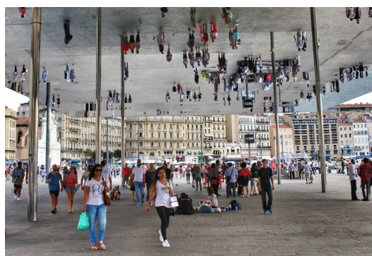
Figura03: Copertura Vieux Port
