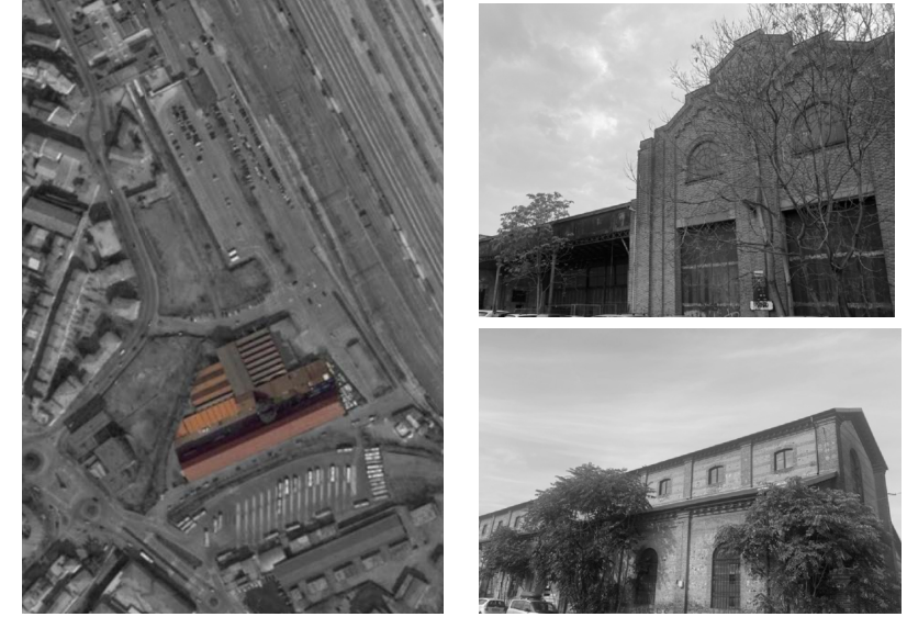
DEPOSITO DE LOCOMOTORI "BERZOLLA"
