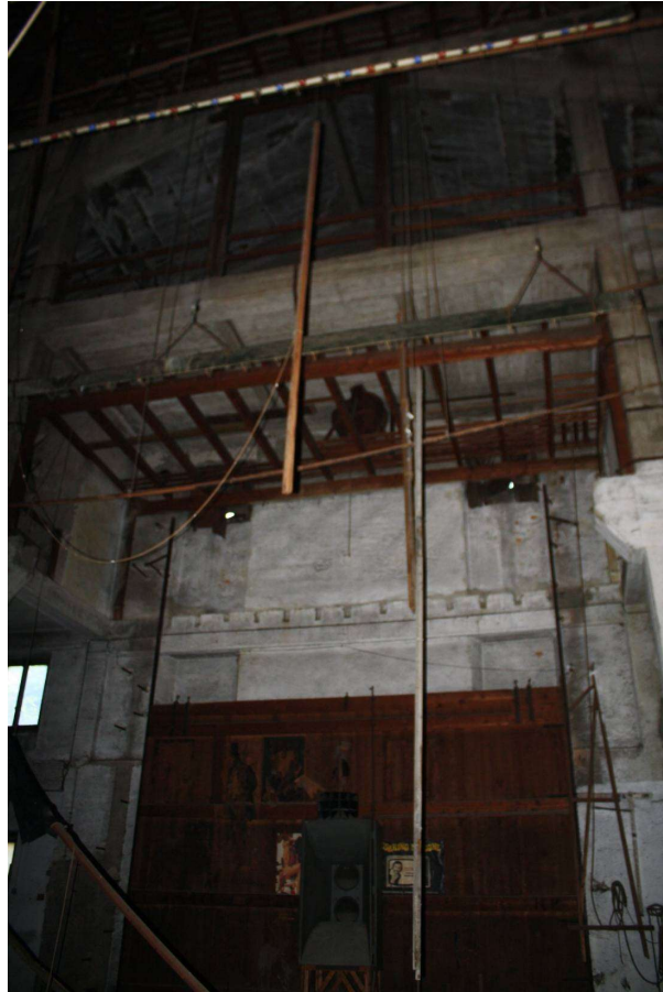
Figura 2.3.1.7: Parte della restante struttura lignea nella torre scenica
