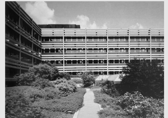
■ 1984, Metanopoli Quarto palazzo per uffici, Studio di Architettura Bacigalupo, Ratti, Alberti, Matti
