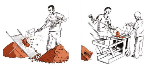
Fig. 3.29 - CEB technique @P. Sémont
