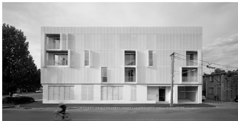
Fig. 7.7.2: Rivestimento apribile in lamiera stirata, Nth Fitzroy
