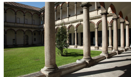
Foto porticato interno
