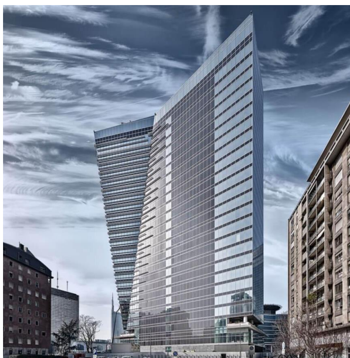
Figura 2—1: Gioia 22, (Milano) – esempio di edificio con facciata continua;
