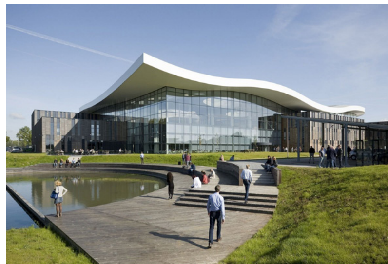
15. Alliander HQ building, vasca di raccolta delle acque e copertura di connessione tra gli edifici preesistenti www.detechniekachternederland.nl
