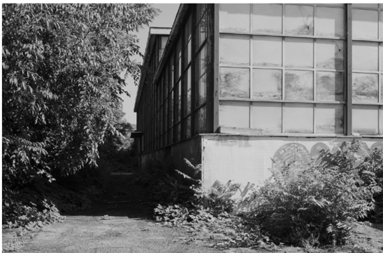
3. A prospetto ovest curtain wall
