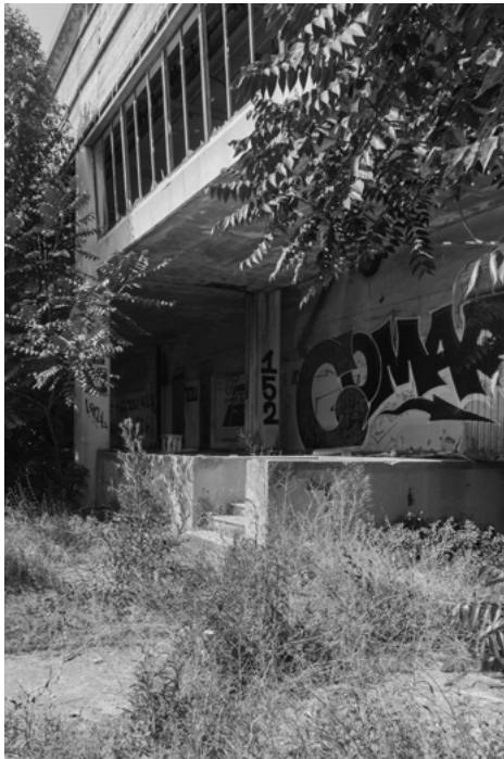
16. Strada rialzata in prossimità della galleria di macellazione dei suini
