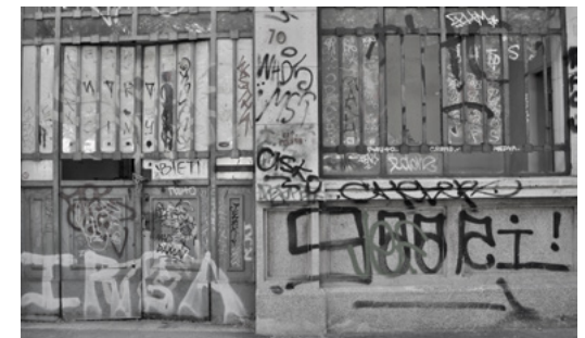
12. Vandalismo: palazzine liberty
