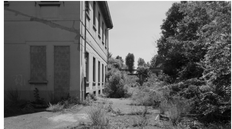
14. Palazzina di uffici amministrativi
