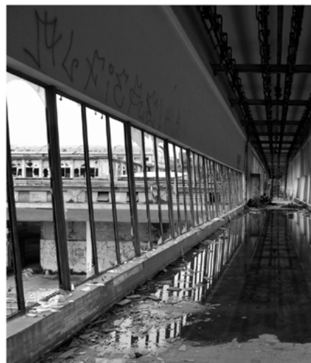
5. C interno della strada rialzata. www.c40reinventingcities.org
