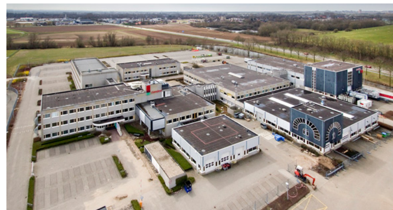
14. Alliander HQ building, fotografia del sito precedente al progetto di rimodernizzazione www.detechniekachternederland.nl
