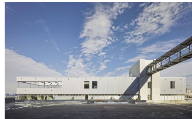
25. Sunset Park Material Recovery Facility, amministrazione e centro educativo www.selldorf.com
