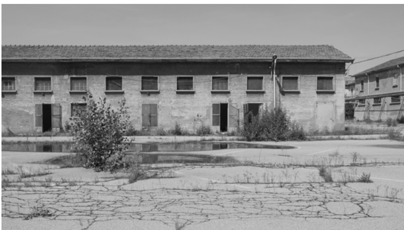
21. Edificio adibito a magazzino e pollaio
