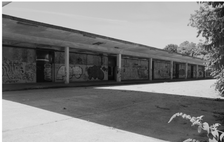
8. F pensilina esterna Nord
