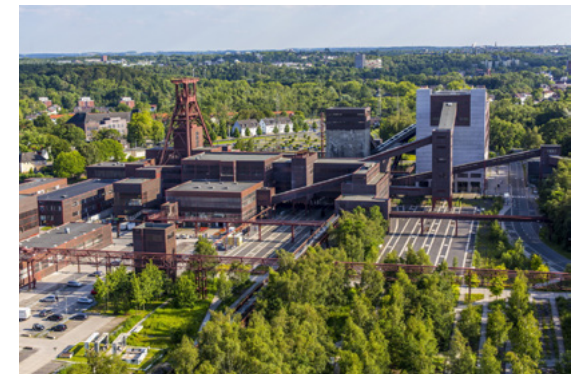
2. Fotografia a volo d'uccello degli edifici industriali e dello spazio pubblico pavimentato. www.zollverein.de
