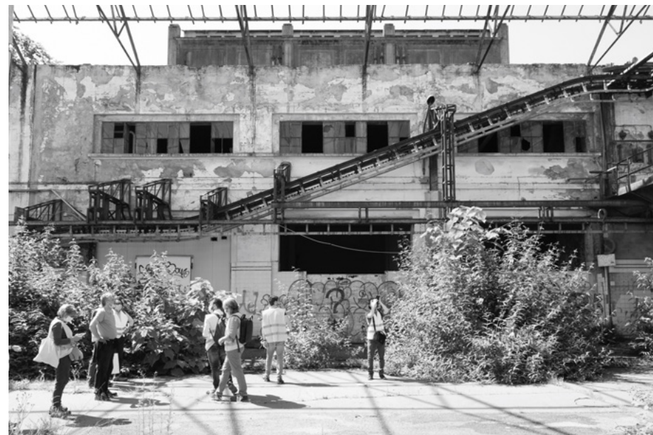
12. Interno della galleria espositiva dall'accesso nord dall'asse centrale
