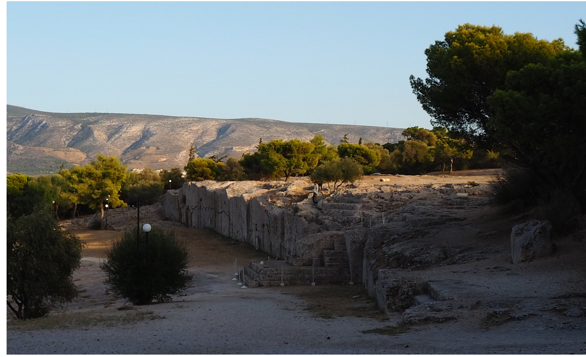
Analisi in dettaglio del sito in cui è possibile vedere la struttura esistente ormai usata dal tempo e i percorsi circostanti nel parco della Pnice
