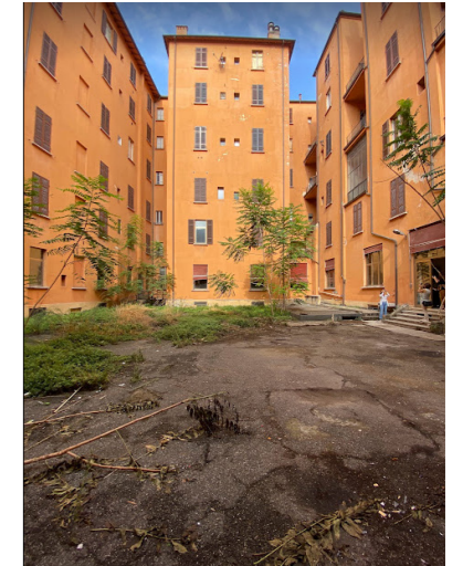
9 - Foto cortile interno Palazzo Aiuto Materno
