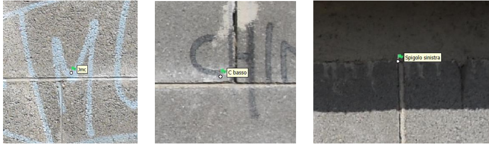
Figura 5.7: Ground Control Points acquisiti sul muro con una stazione totale
