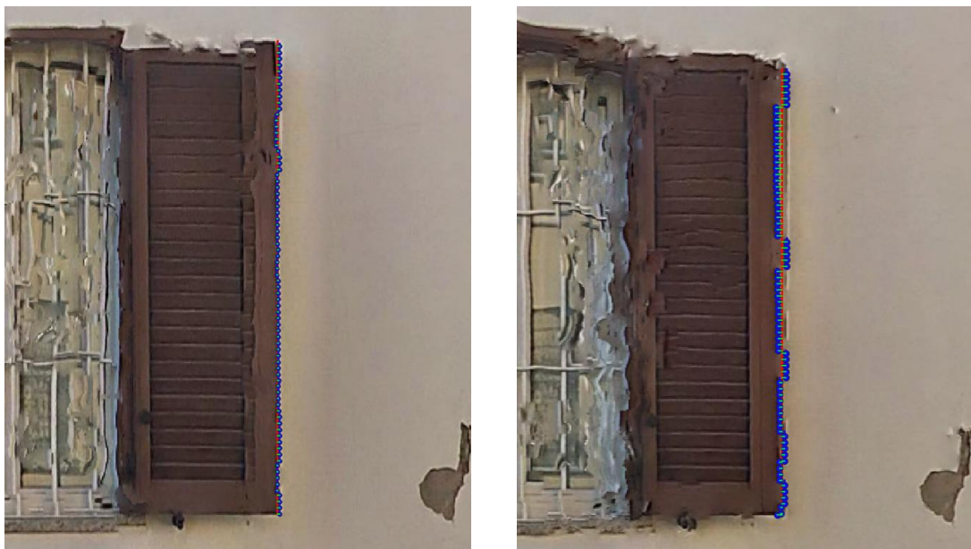
Figura 7.8: A sinistra, distanze dalla linea di riferimento della persiana per l'ortofoto dalla nuvola di punti LiDAR; a destra, la stessa dalla nuvola di punti fotogrammetrica
