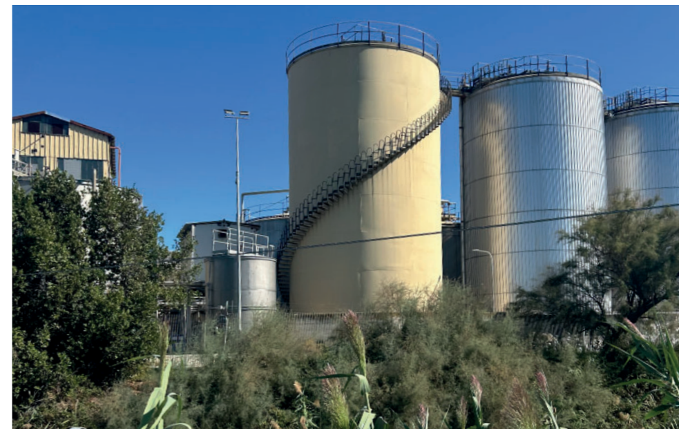
Figura 7 - Silos di stoccaggio dell'industria chimica Eco Fox, 20 Settembre 2025
