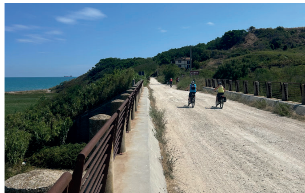
Figura 39 - Ponte sopra il Fiume Sinello, 23 Agosto 2025
