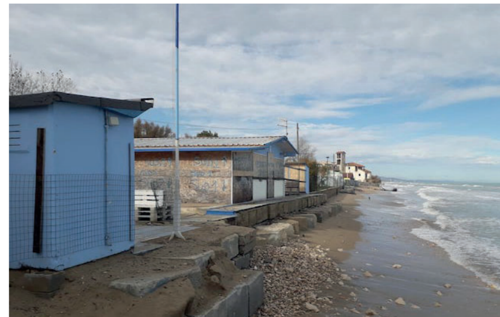
Figura 6 - Costruzioni a ridosso della linea di costa a Silvi Marina (TE)
