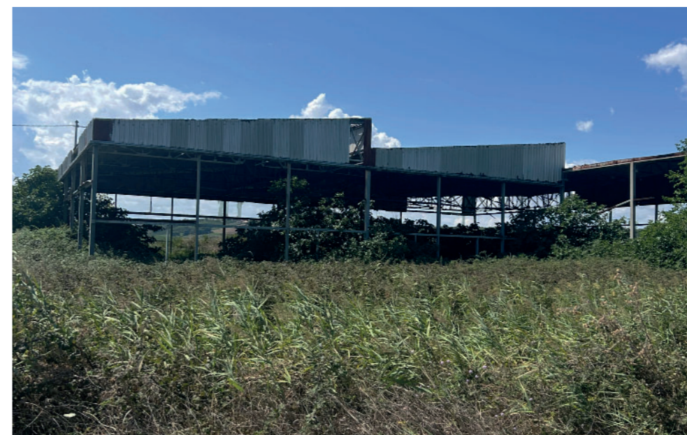
Figura 4 - Capannone abbandonato e vegetazione spontanea, Casalbordino (CH), 23 Agosto 2025
