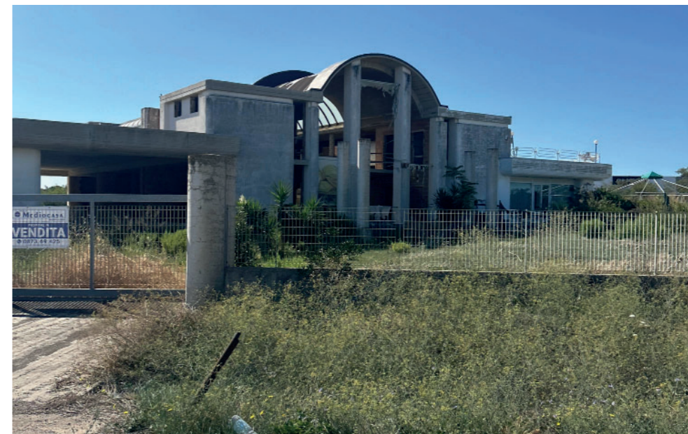
Figura 37 - Edificio inutilizzato, zona industriale di Vasto, 20 Settembre 2025
