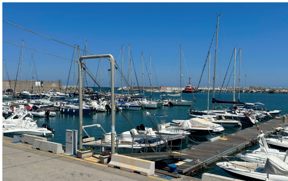
Figura 25 - Vista del lato interno del molo Mandracchio, 23 Agosto 2025
